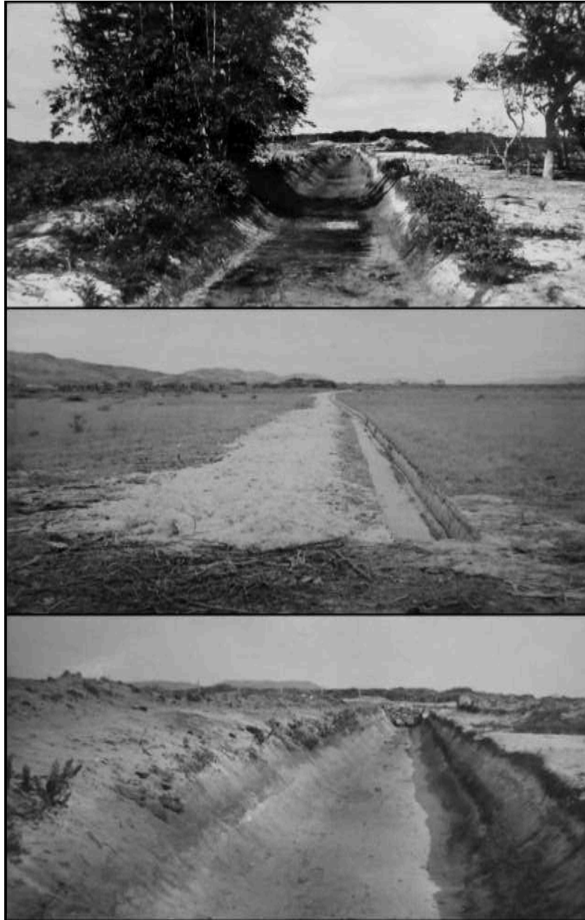
Figura 11: Valas de drenagem, de diferentes tamanhos e profundidades. Década de 1960.
