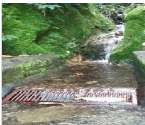
Fotografía 12. Fuente de abastecimiento y bocatoma acueducto Motilón Centro Fuente: Elaboración propia
