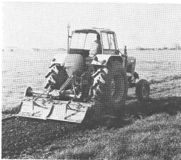
Terreinvoorbereiding met trekker en frees.
