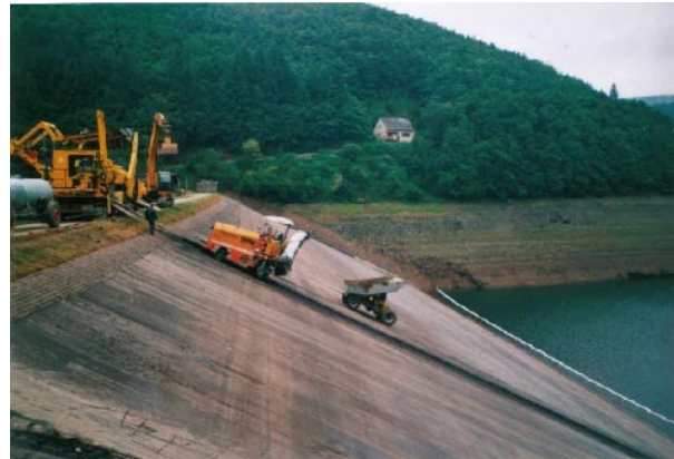
foto 9: Asfaltering dam
