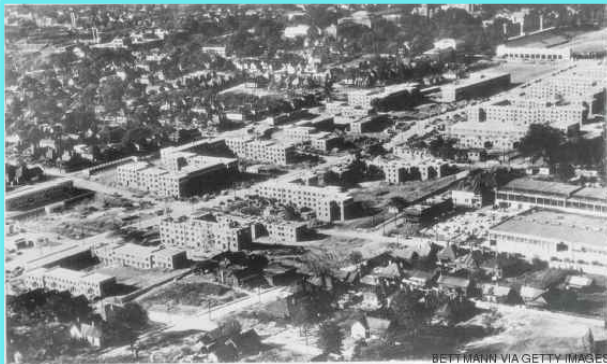
Se construye el primer complejo de viviendas sociales de EEUU. Roosevelt.
