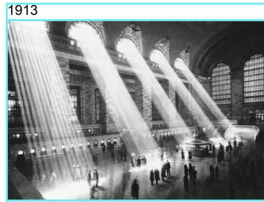
Se construyeron la red de metro y las vías de la Gran Estación Central. Nueva York se convirtió en la ciudad más poblada del mundo, desbancando a Londres de la primera posición.
