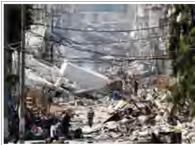
Figure 1.8 Quelques bâtiments endommagés dans la ville de Port-au-Prince, tirée d'un article sur le site planete gaia (sismologie)
