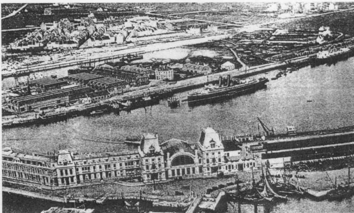
Fig. nr. 129. Haven Oostende, omstreeks 1929. Midden, de werkhuisen van de Scheepsbouwdienst van het Zeewezen. Rechts de bevoorradingsposten voor de pakketboten van de Oostende-Doverlijn op de oosteroever. Het Zeewezendok is reeds gedeeltelijk uitgebreid (de oostelijke betonnen kaaimuur is reeds gebouwd). Bemerkt dat de oude Vuurtorenwijk nog niet volledig gesloopt is.
