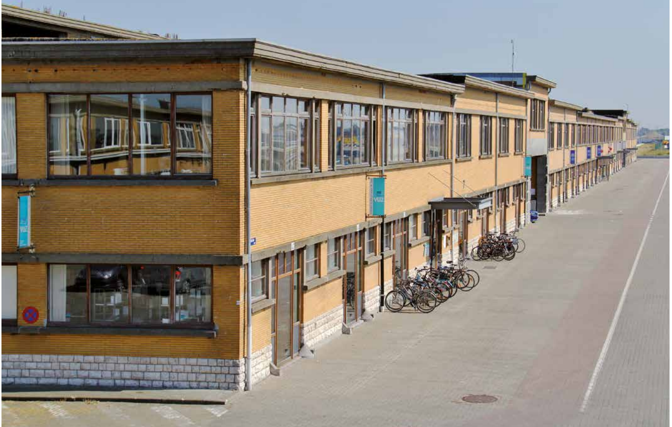
HET VLIZ ZAL, VANAF 2021 , samen met de internationale partners, het Streekhuis Kust en ILVO-Visserij, gehuisvest worden in een gedeelde nieuwbouw in de Ankerstraat in Oostende.
