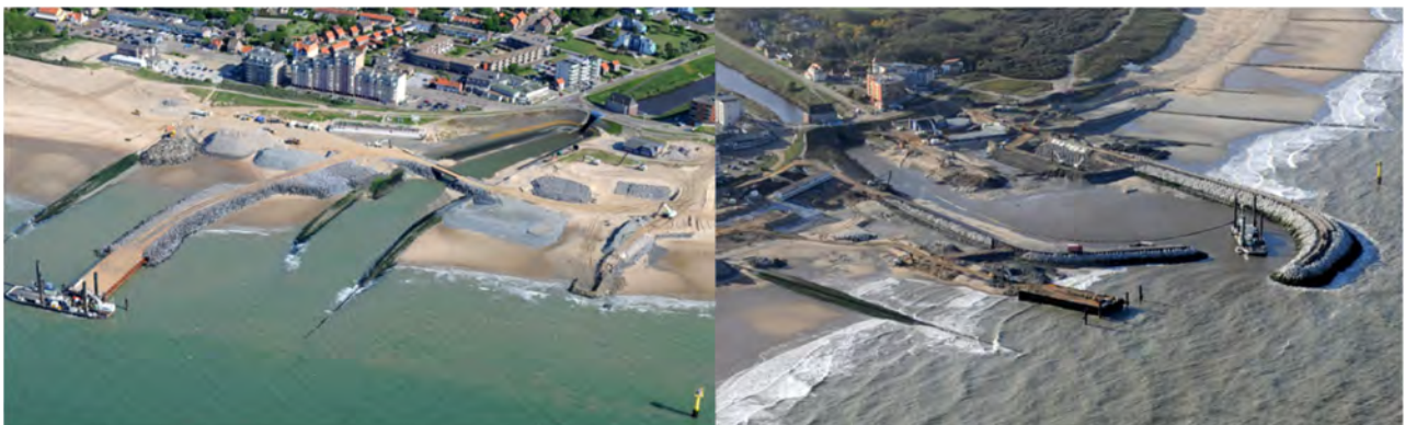
Figuur 21: Aanleg van de strekdammen en de golfbrekers ten behoeve van de sluis en jachthaven nabij Cadzand.
