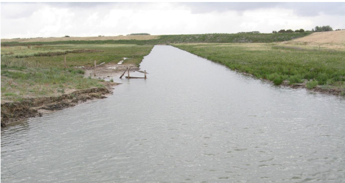
Foto. Tot aan- en afvoerkanaal omgevormde zuidelijke zijgeul van het Zwin (E. Cosyns, 11 september 2013, foto genomen van boven op de nieuwe stuw richting zuidoost)
