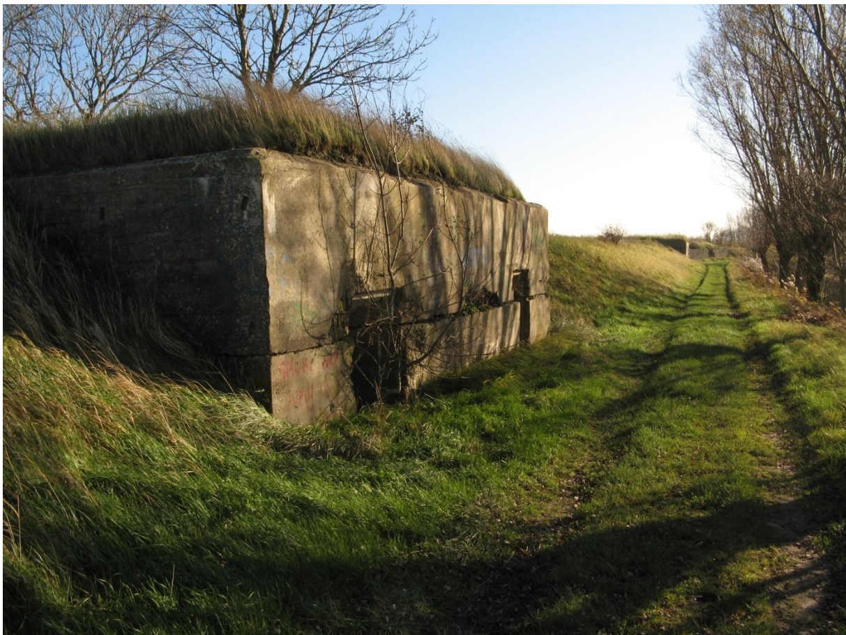
Foto. In de Hazegraspolderdijk ingebouwde bunkers, die een aanzienlijk potentieel als winterverblijfplaats voor vleermuizen hebben (foto E. Cosyns, november 2012).
