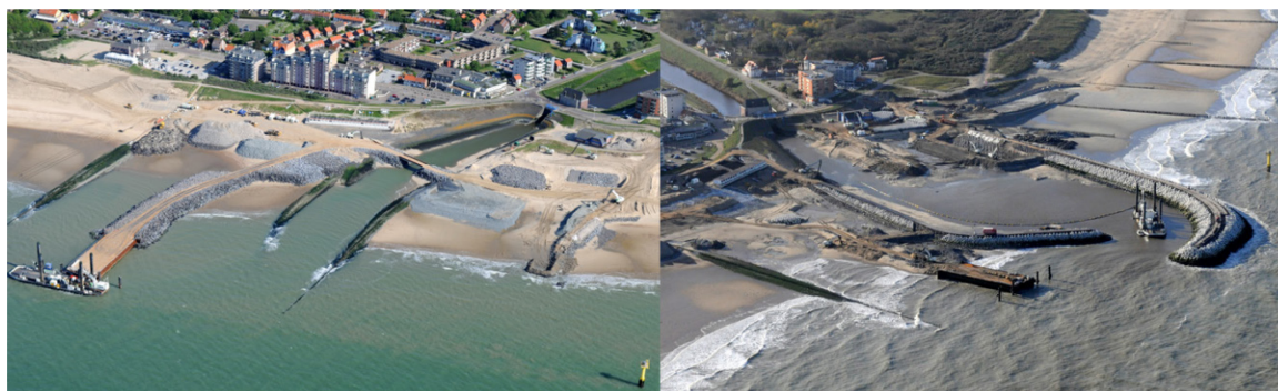
Figuur 21: De strekdammen bij de uitwateringssluis te Cadzand-Bad in de situatie tot medio 2015 (links, vanuit het zuid westen; het werkschip ligt aan een tijdelijke dam) en de golfbrekers ten behoeve van de sluis en jachthaven (rechts, vanuit het noordwesten) in de huidige situatie.
