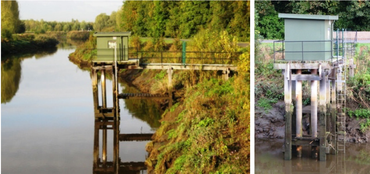
Figuur 29 - Tijmeetinstallatie te Lier Molbrug op de Beneden Nete
