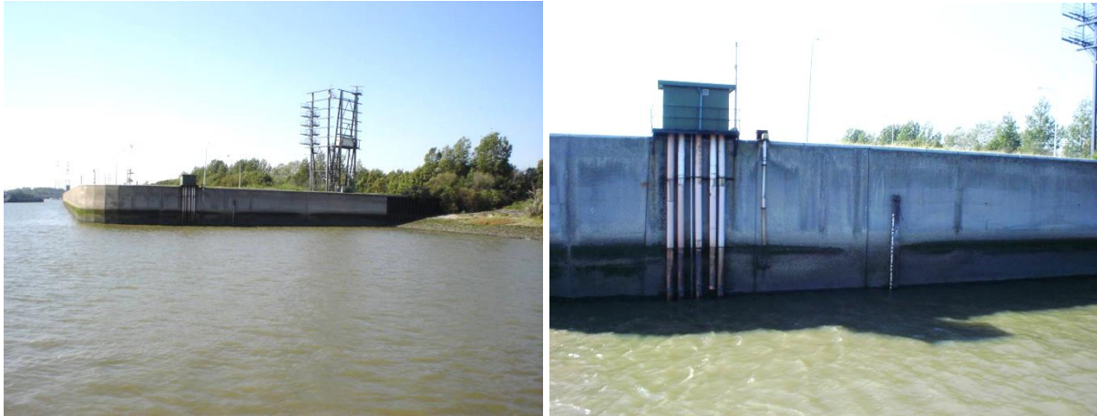
Figuur 10 - Tijmeetinstallatie te Kallosluis op de Beneden Zeeschelde
