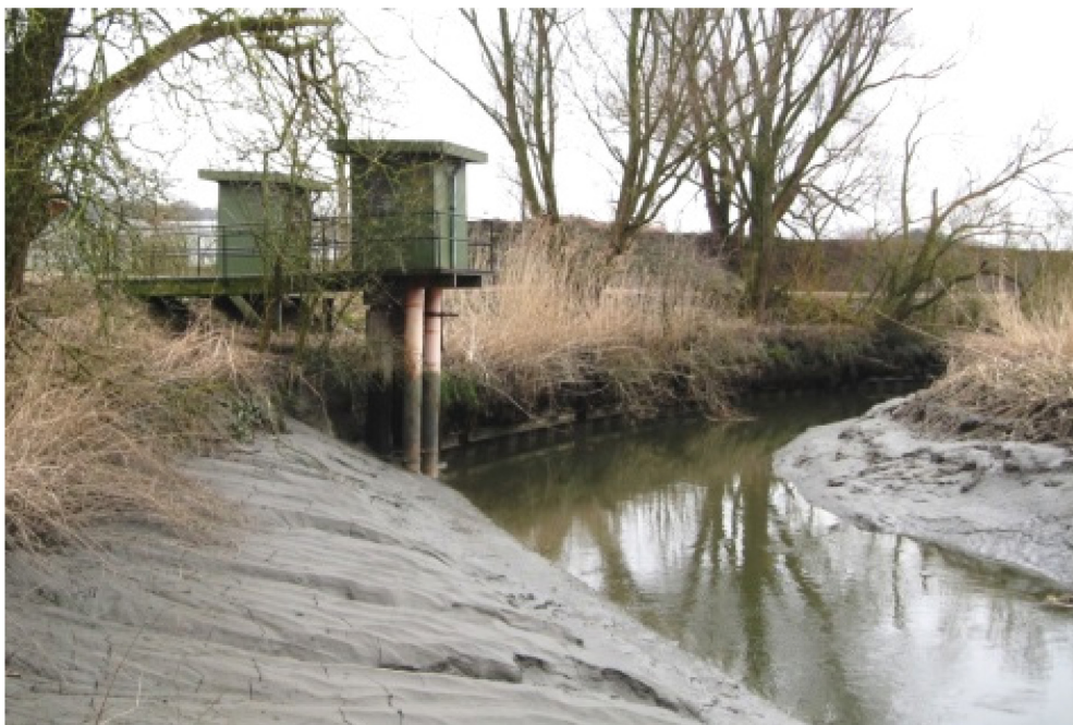
Figuur 41 - Tijmeetinstallatie te Waasmunster Manta op de Durme
