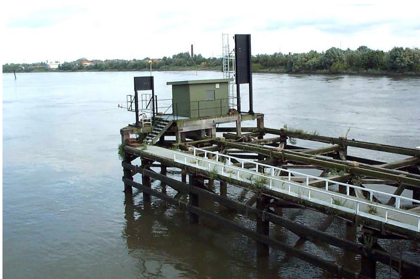
Figuur 26 - Tijmeetinstallatie te Boom op de Rupel.
