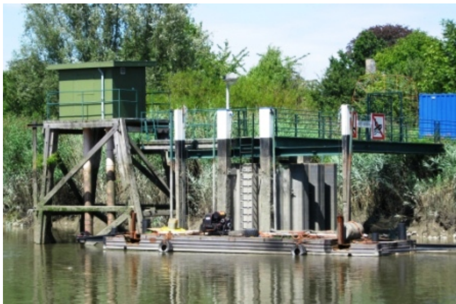
Figuur 39 - Tijmeetinstallatie te Tielrode op de Durme
