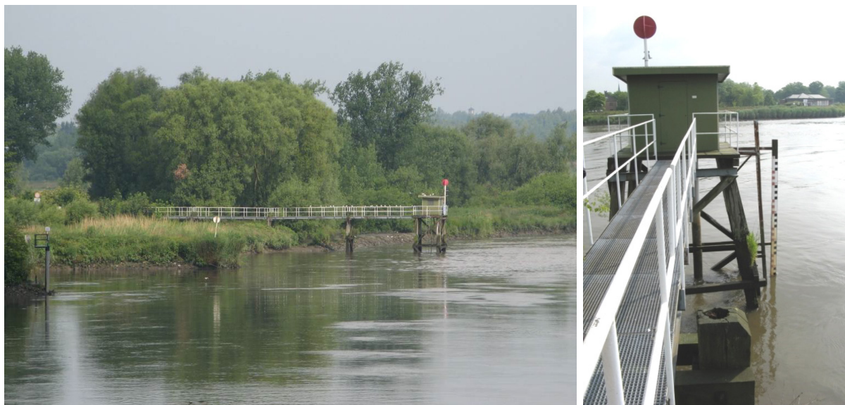
Figuur 27 - Tijmeetinstallatie te Walem op de Rupel
