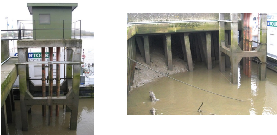
Figuur 15 - Tijmeetinstallatie te Temse op de Boven Zeeschelde.
