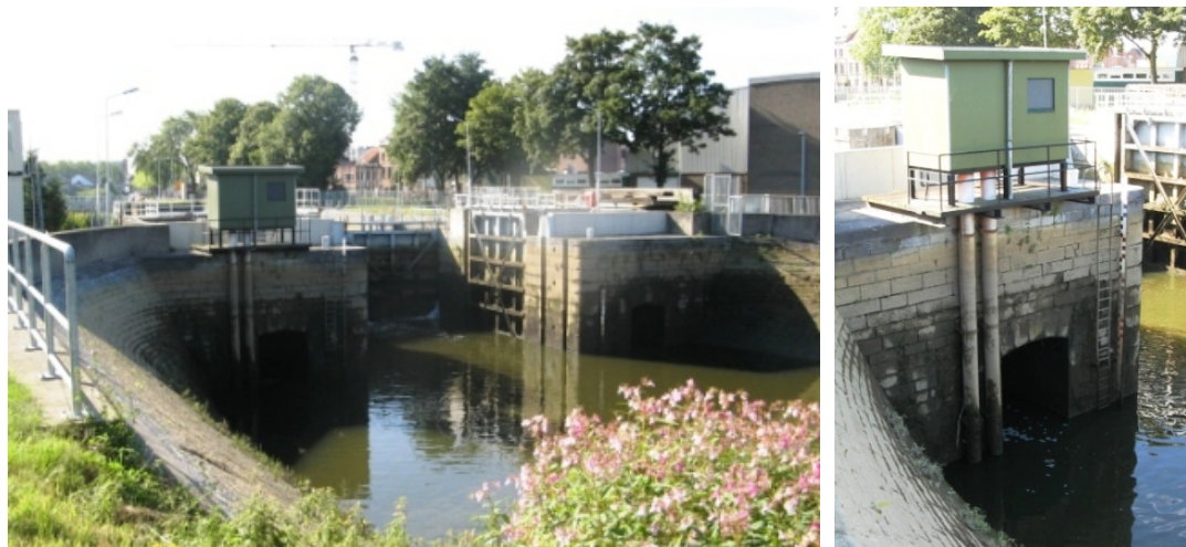
Figuur 33 - Tijmeetinstallatie te Mechelen Benedensluis op de Dijle
