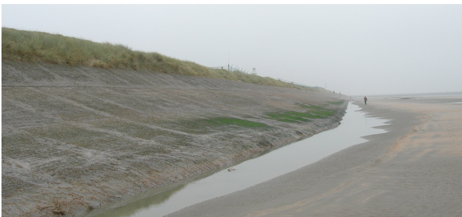
Fig. 10 - Dune foot strengthening off Lombardsijde (Van der Biest K., 2007)
