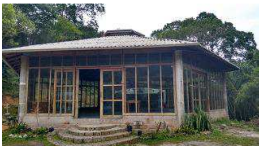
Figura 14 – Centro de Convivências
