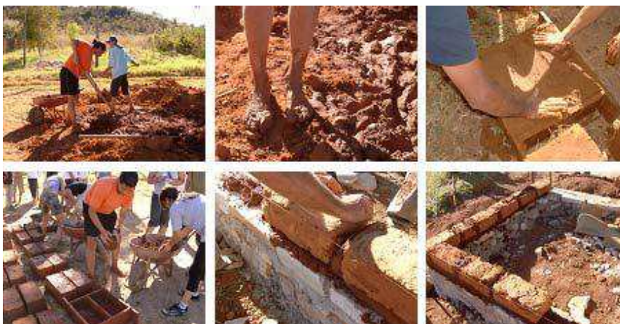
Figura 4 – Construção de blocos estruturais em adobe.
