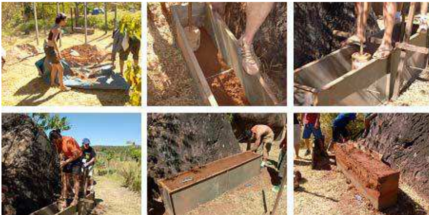
Figura 8 – Construção de parede estrutural em taipa de pilão.
