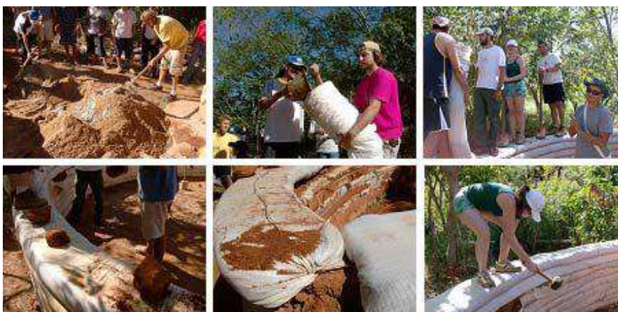
Figura 5 – Construção de parede estrutural em superadobe.
