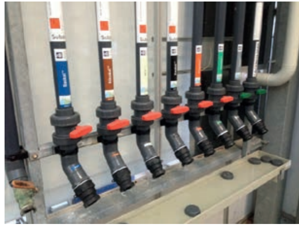
Figuur 12 Koppeling voor aanleveren van vloeibare meststoffen. In veel gevallen zitten de aansluitingen buiten het bedrijf.
