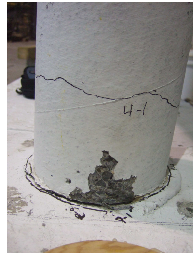
Vue du côté droit, endommagement en compression
