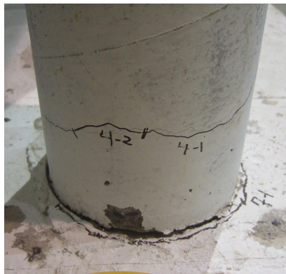
Vue du côté gauche, endommagement en compression
