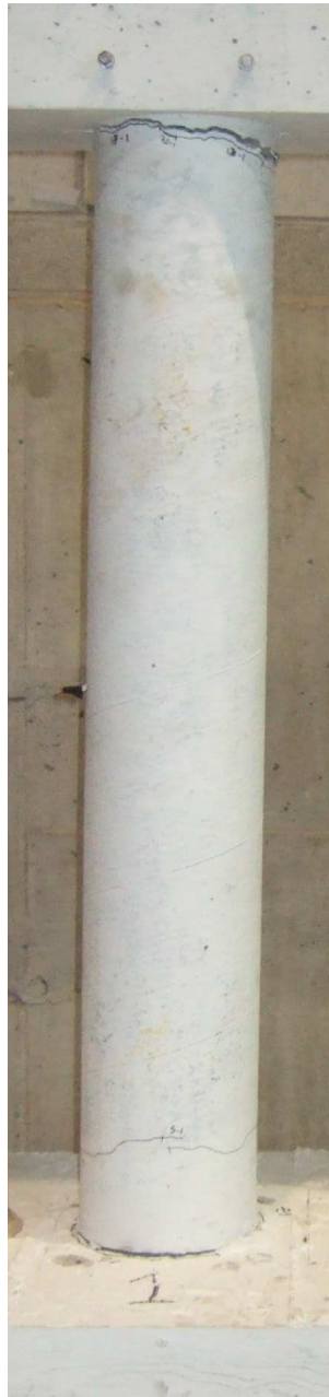
Poteau 1, vue en élévation
