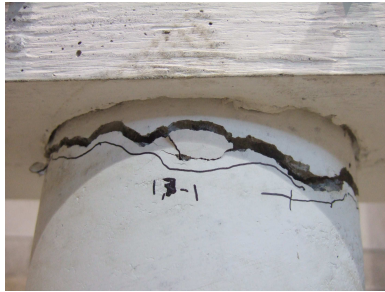
Agrandissement vue en élévation, haut du poteau 2
