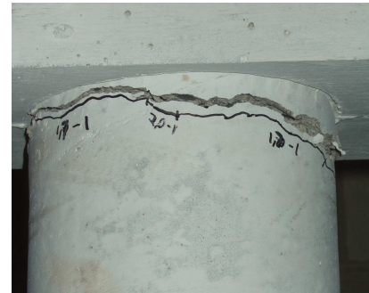
Agrandissement vue en élévation, haut du poteau 1
