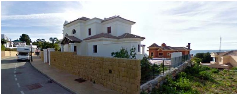
Figure 5. Urbanización Puerto de Estepona
