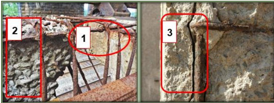
**Fig. 1. Consecuencias desencadenadas tras el proceso de corrosión de las varillas de acero de refuerzo embebidas en concreto (<http://www.enriquealario.com/carbonatacion-de-hormigon/#lightbox/0/>).**
