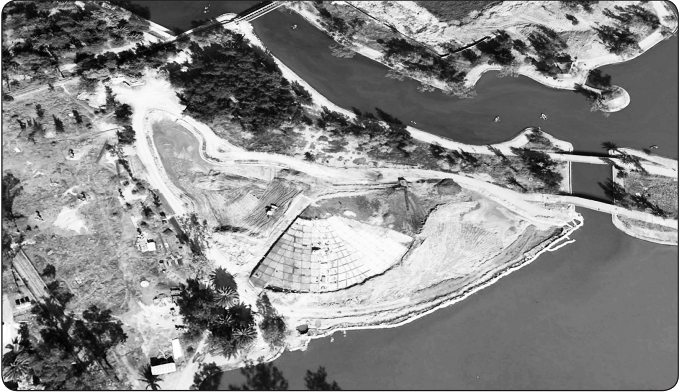
Figura 9. Vista aérea durante la fase de delimitación y adecuación del sitio de construcción del STHA. Fuente (Google earth).
