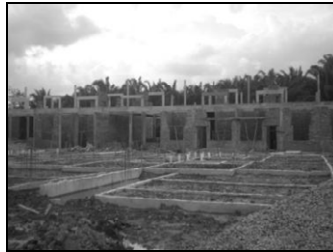
Fig. 2. Construction Site B
