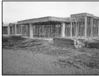
Fig. 1. Construction Site A
