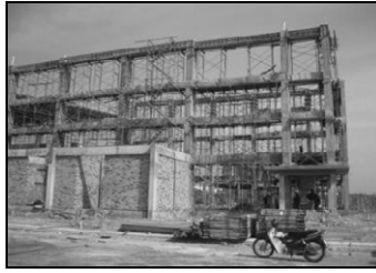
Fig. 3. Construction Site C
