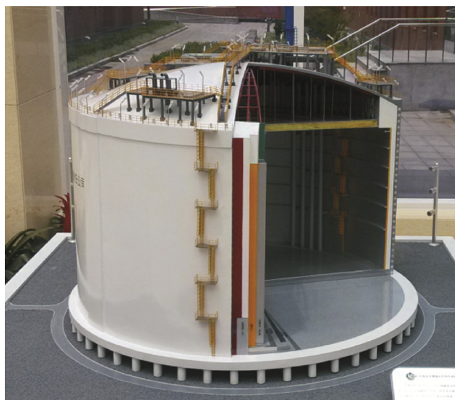
Fig. 1. Model of a full containment LNG tank.
