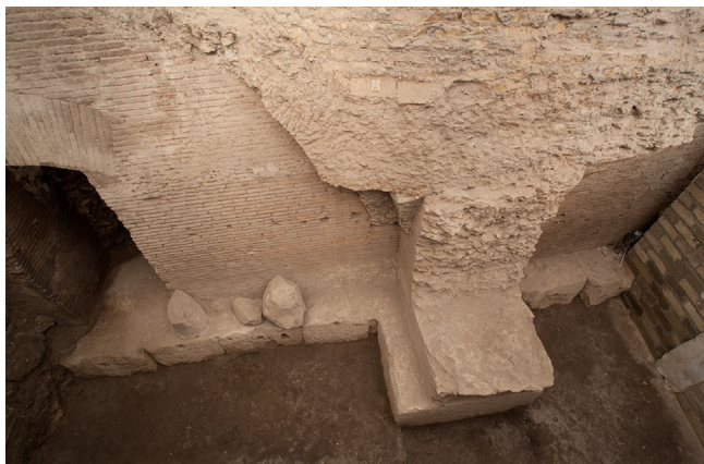
Figure 5 Palazzo Valentini, area along vicolo di S. Bernardo: Roman imperial walls in opus latericium .
