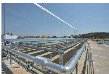
Fig. 5. Details of LFR installation 0,7 MW (CNIM – F - La Seyne)
