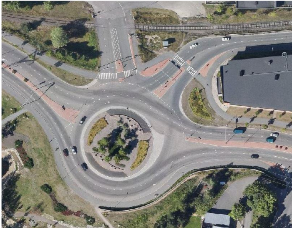
Kuva 18. Pallon kiertoliittymä 2015. (Kuva: Lappeenrannan kaupunki)
