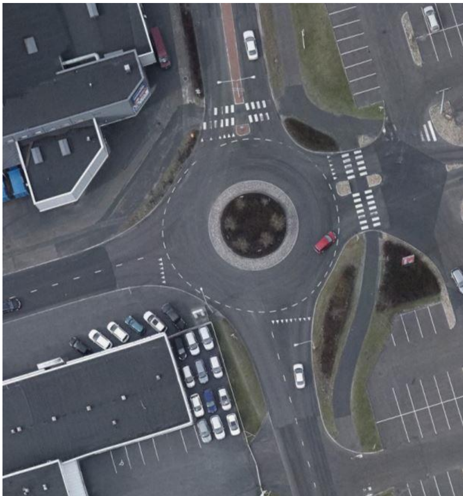
Kuva 24. Citymarketin liittymä kiertoliittymänä 2014. (Kuva: Lappeenrannan kaupunki)
