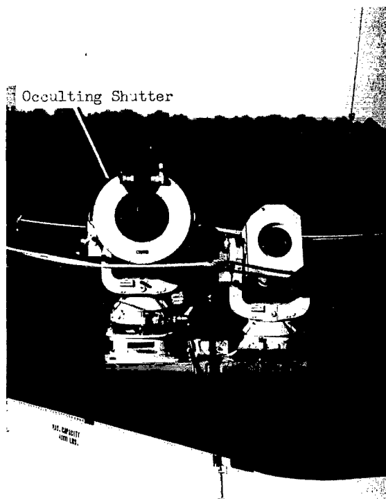
L-61-8237 Figure 7.- The 210-mm focal length f/4.2 cameras.
