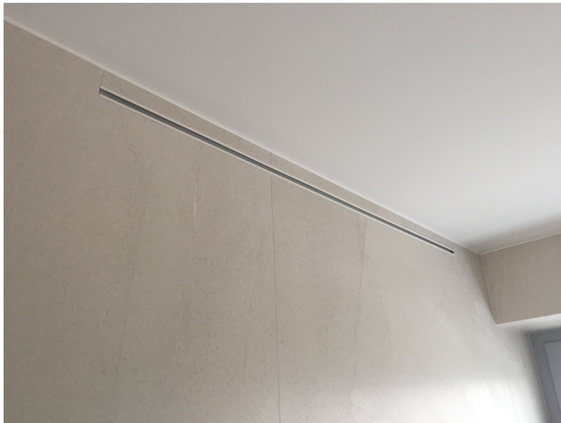
Slika 45: Primer vgradnje linijskega difuzorja LD-15 v praksi
