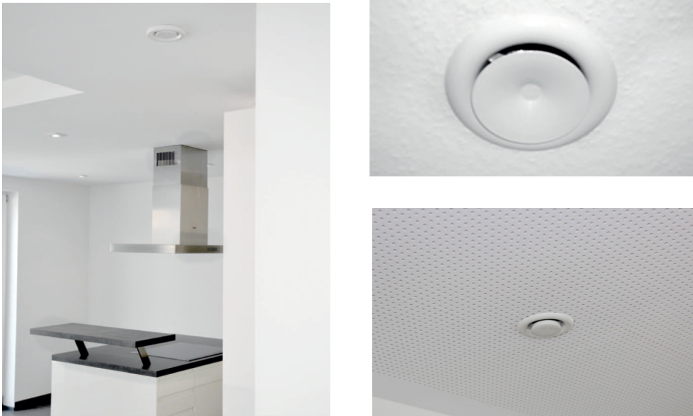
Slika 17: Odvodni prezračevalni ventili[6]
