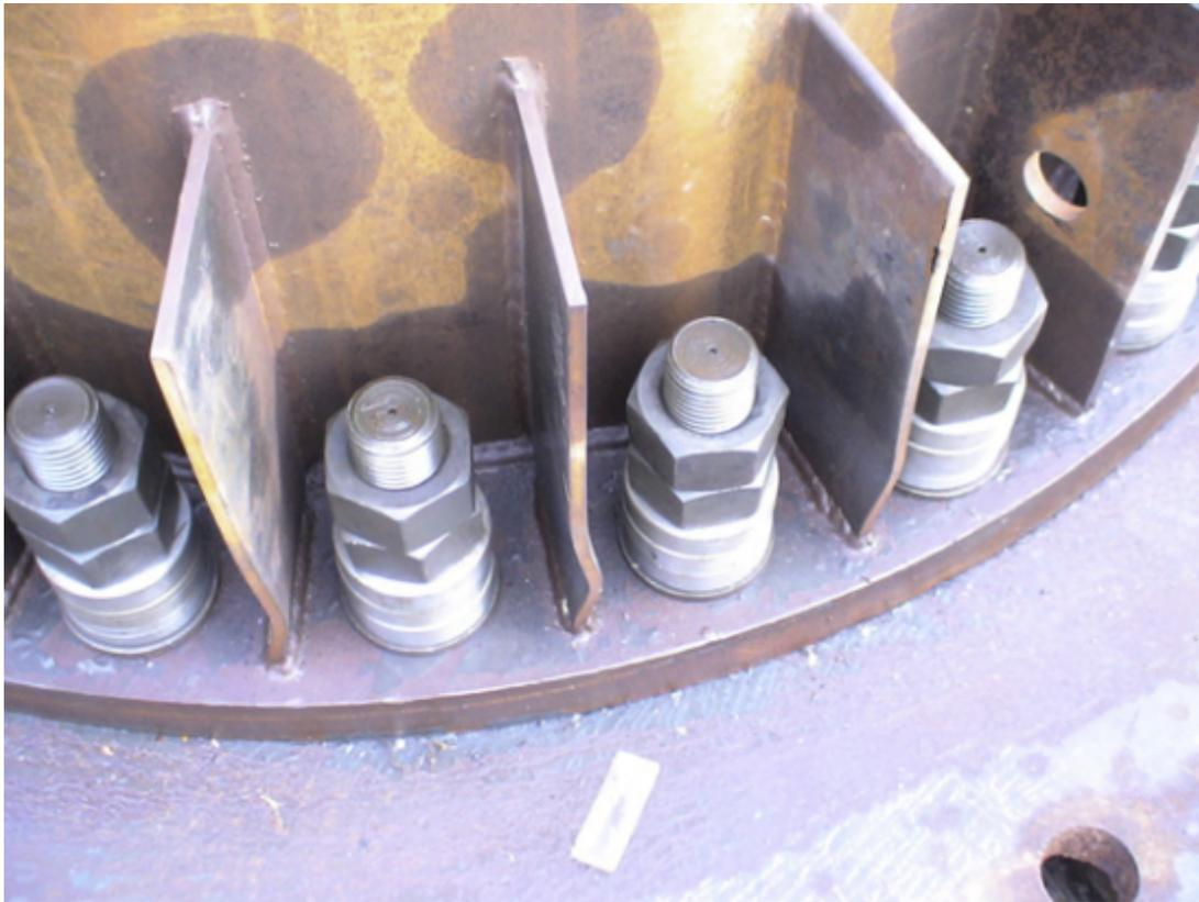
Figure 2.11 Présence de voilement local dans les raidisseurs de la connexion à la base d'un pylône tubulaire de 220 kV [Mohan *et al.*, 2008]
