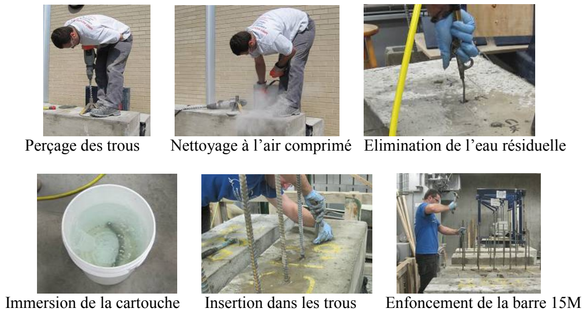
Figure 4.4 Procédure d'installation des ancrages
