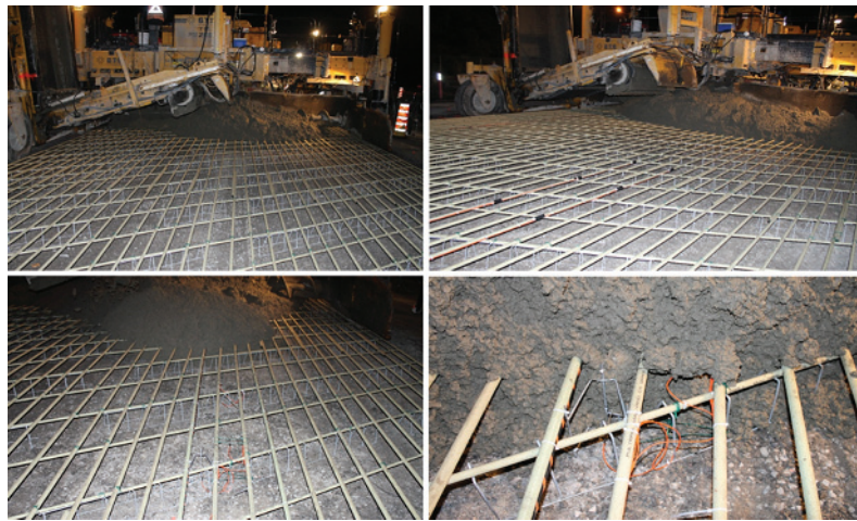
Figure 3.10 Bétonnage de la section de la dalle d'essais
