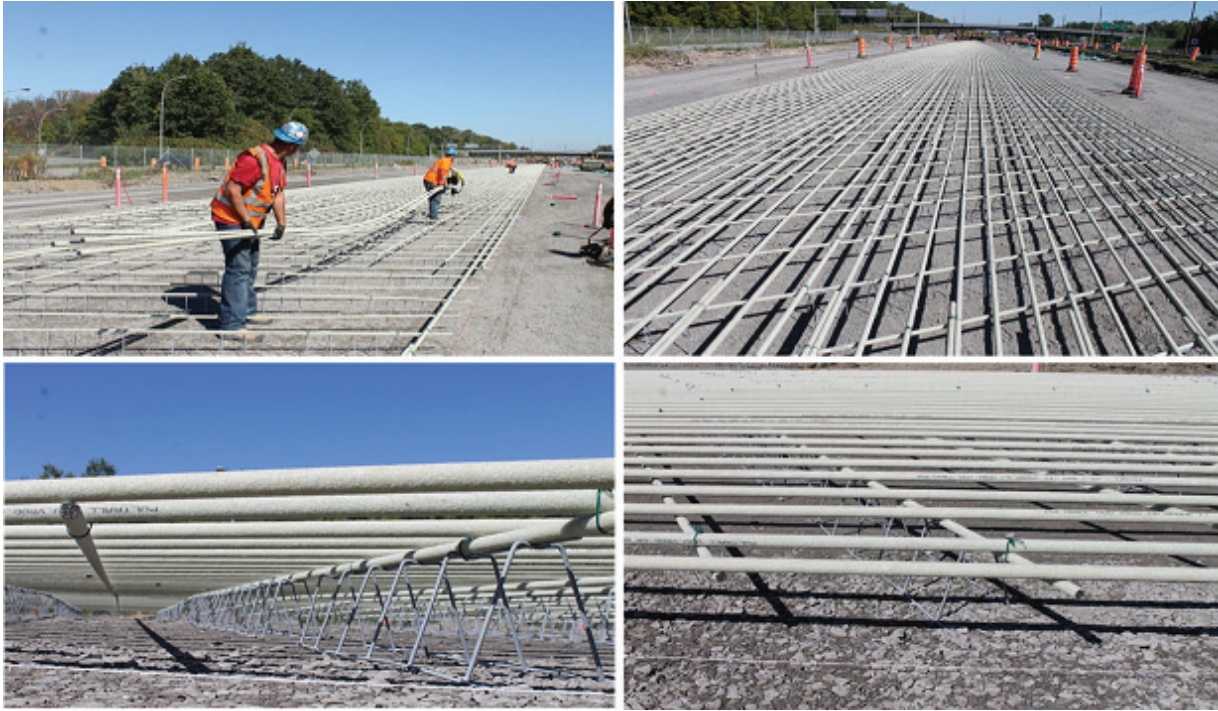
Figure 3.5 Installation des barres d'armature en PRFV
