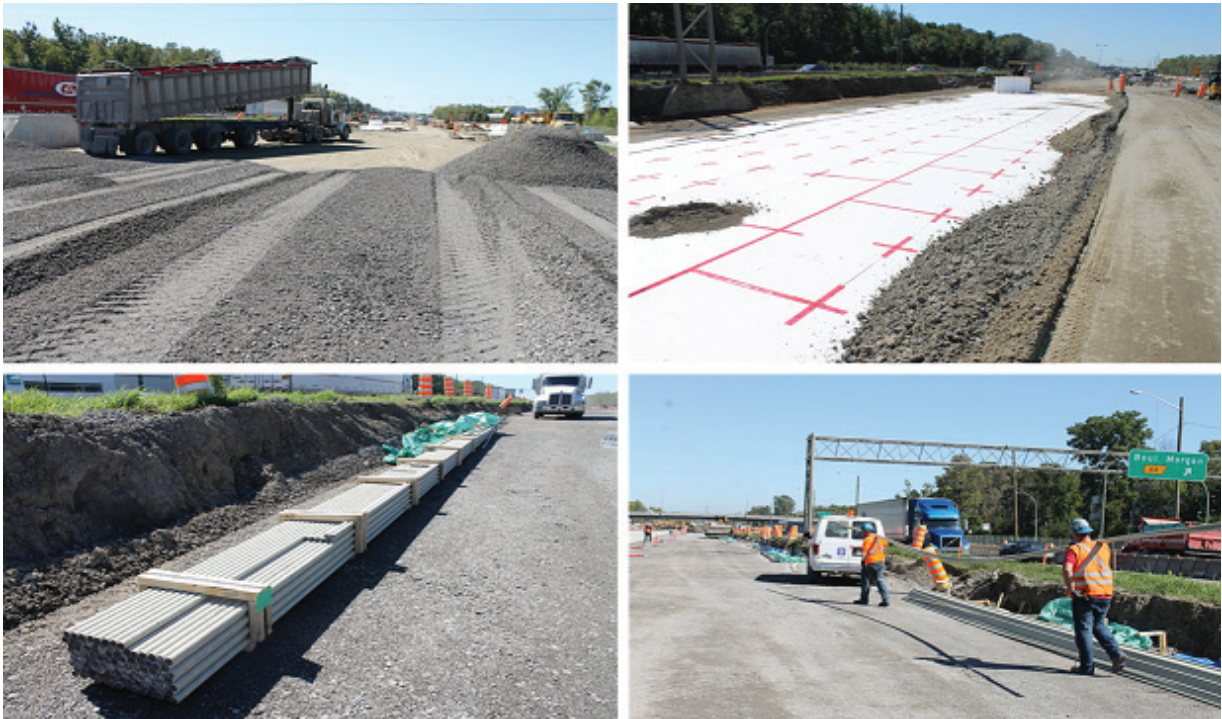
Figure 3.4 Chantier de l'autoroute 40 à Montréal
