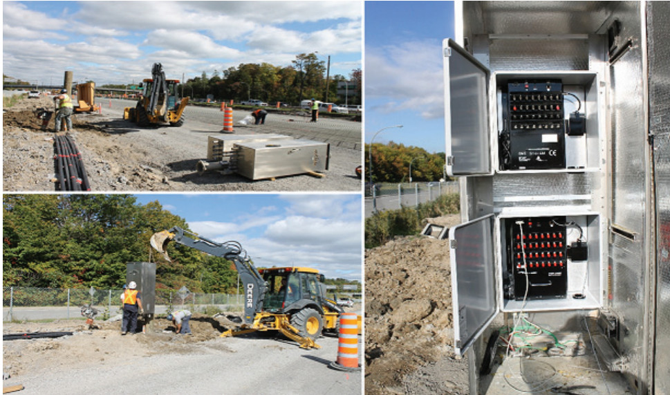
Figure 3.8 Installation du coffret d'instrumentation
