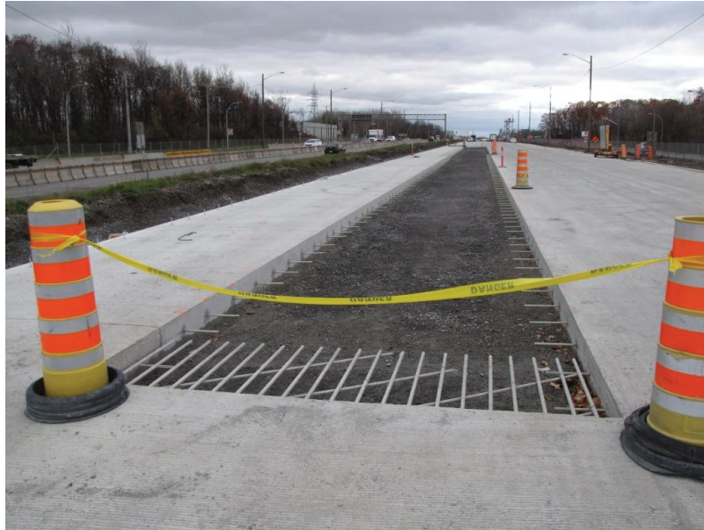
Figure 3.13 Zone endommagée sciée
