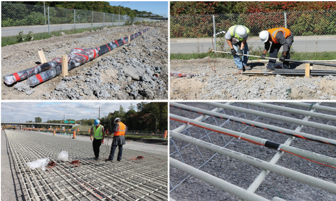
Figure 3.6 Installation des six barres d'armature en PRFV instrumentées
