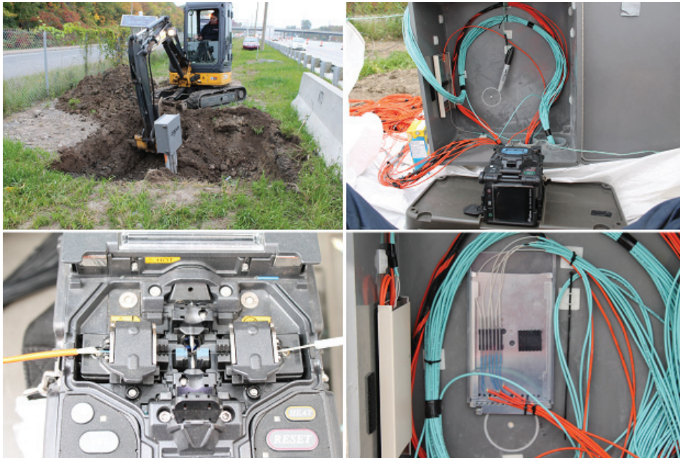
Figure 3.16 Soudure des fibres optiques brisées
