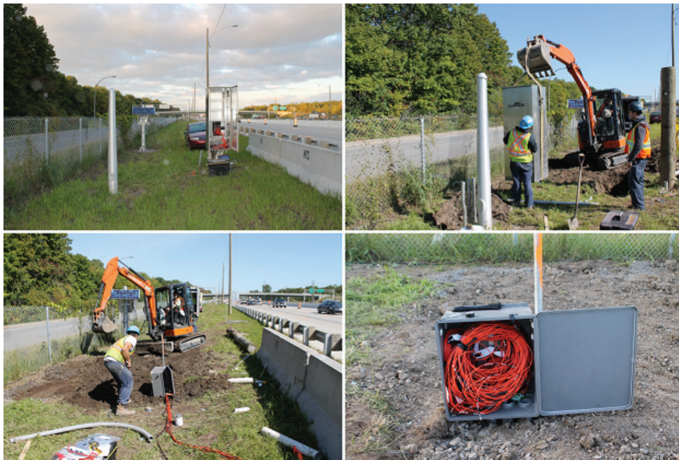
Figure 3.15 Déplacement du boîtier d'instrumentation et boîte de jonction
