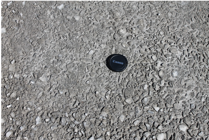
Figure 3.9 Assise de la dalle de chaussée en béton armé continu
