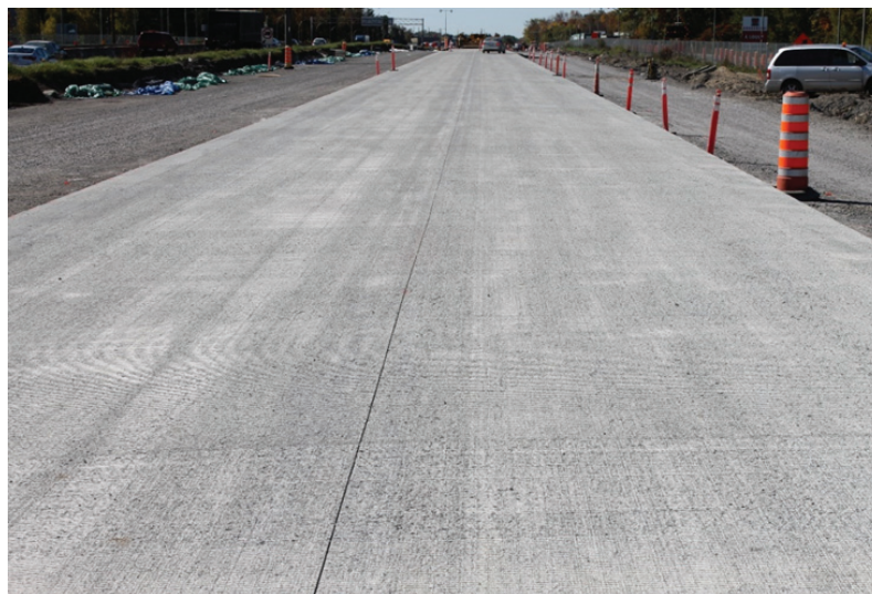
Figure 3.11 Section d'essais bétonnée
