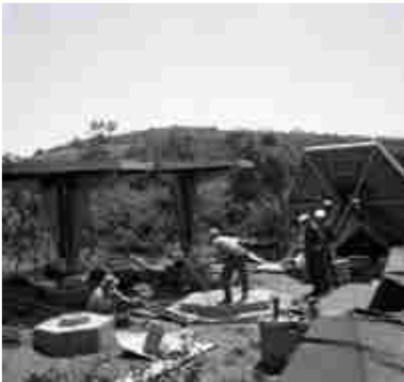
Figura 2.5: L'Esagono in fase di montaggio, (Serie n°4, 8)
