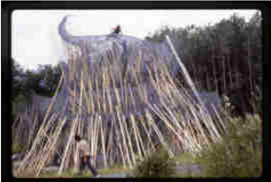
Figura 2.39: Gli studenti di Giorgini, preparano la struttura in rete tramite l'utilizzo di pali in legno, (Serie n°4, 57).
