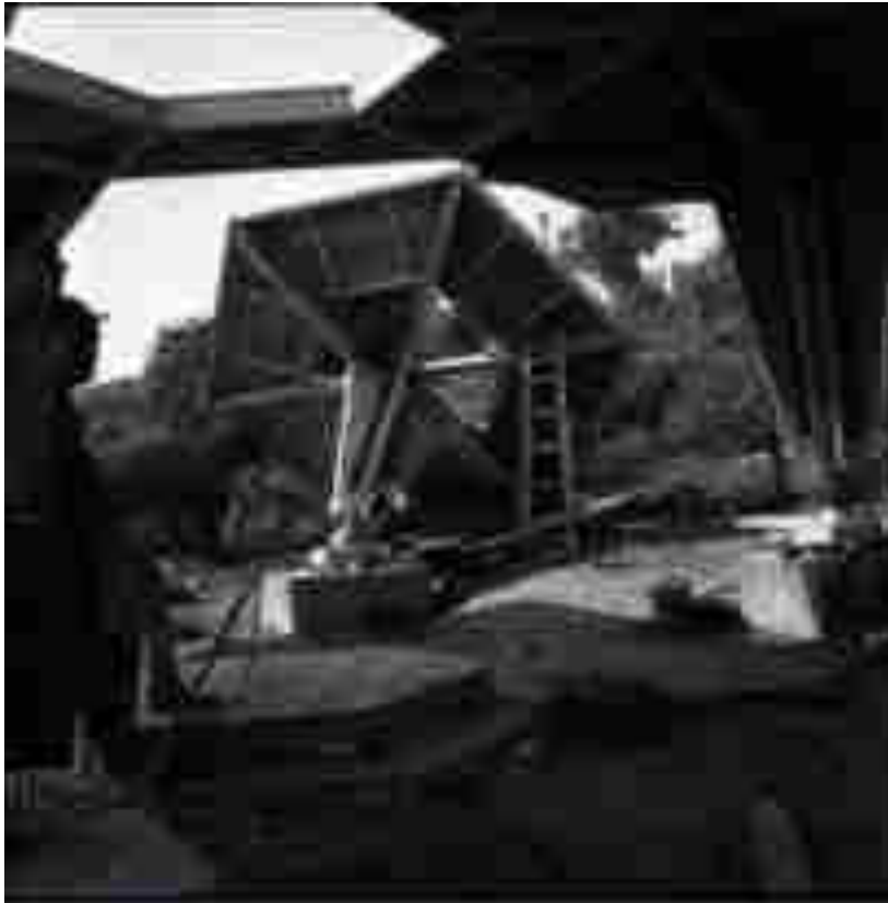
Figura 2.4: L'Esagono in fase di montaggio, (Serie n°4, 8)
