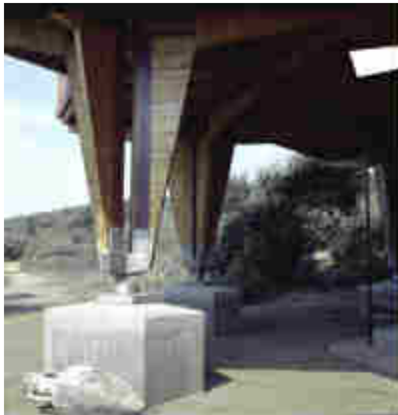
Figura 2.9: Dettaglio dell'Esagono; base in cemento, cerniera e pilastro in legno su cui poggia uno dei sei esagoni. (Serie n°4, 8)
