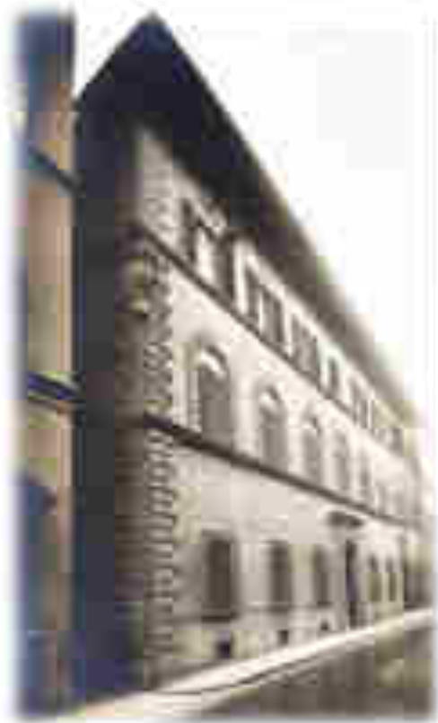
Figura 1.3: Palazzo Ridolfi: Situato al civico n°13 di Via Maggio, Firenze, dove l'architetto Giorgini nasce e trascorre la sua infanzia. (Serie n°12, 2)
