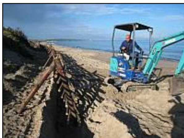
Realizzazione delle graticciate a protezione della duna, Sardegna (Foto Ispra, 2009 b).
