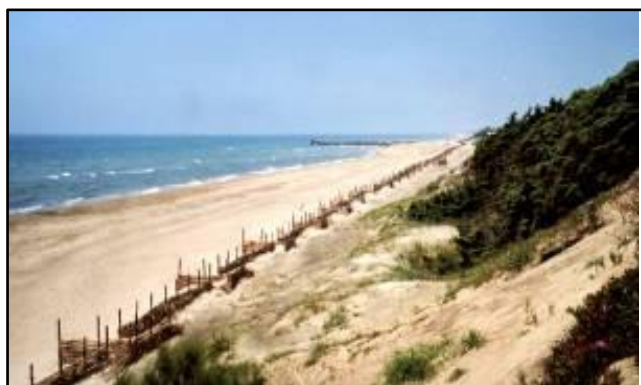
Costruzione di barriere basali in viminate, chiusura dei varchi mediante palizzate e realizzazione di schermi frangivento nel Parco Nazionale del Circeo (Foto Puglisi , 2000).
