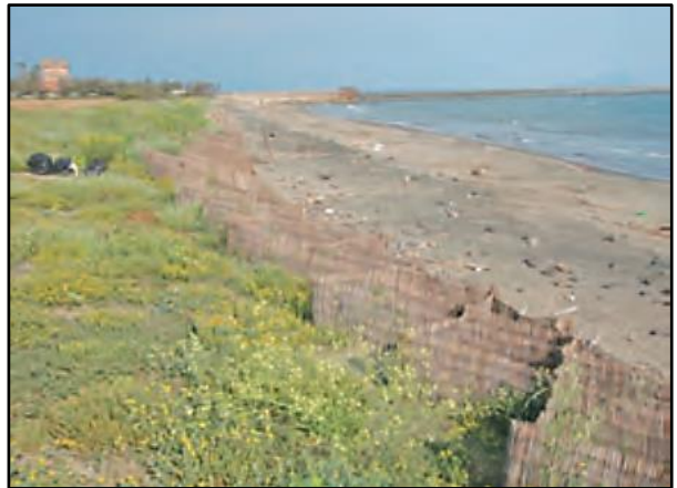
Frangivento a scacchiera per ricostruire la morfologia dunale (sx), la stessa struttura (dx) quattro anni dopo dalla sua realizzazione (Foto Bovina in Ispra 2009 a).
