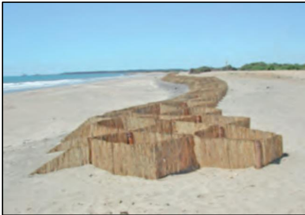
Frangivento a scacchiera per ricostruire la morfologia dunale (sx), la stessa struttura (dx) quattro anni dopo dalla sua realizzazione (Foto Bovina in Ispra 2009 a).
