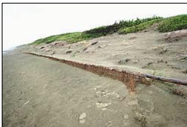
Difesa al piede della duna con paleria di legname e stuoia in cocco (Foto di Bovina in Ispra 2009 b).
