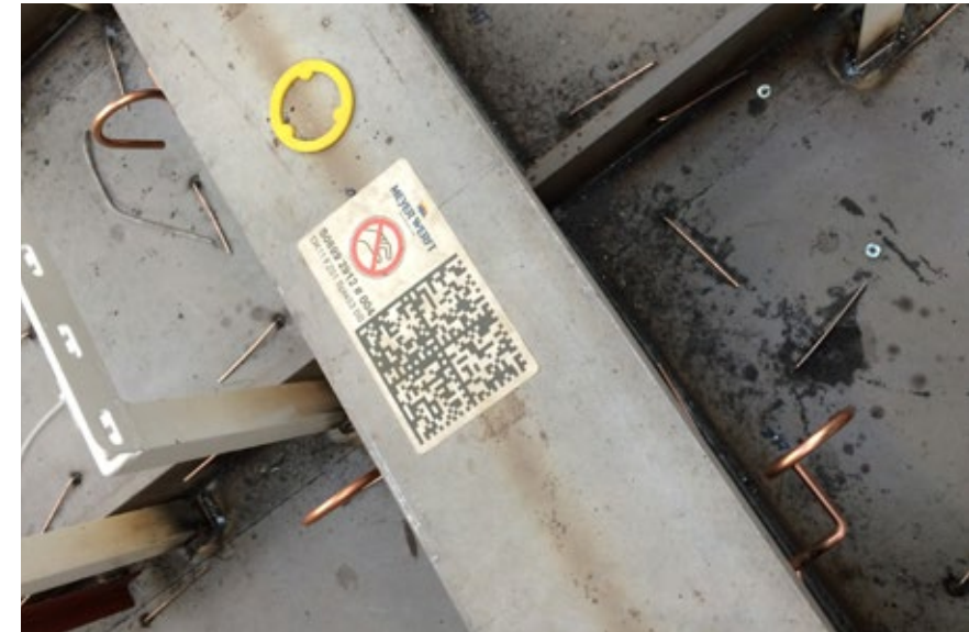
Abbildung 2: Einbringung Zentrierring und Beschriftung in Sektion
