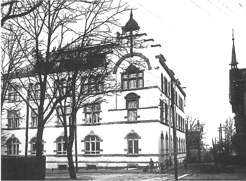
Abbildung 32: Fertiggestelltes Huttenmännisches Gebäude. Rechts das Haus der Diakonissen, heute chinesisches Kulturzentrum
