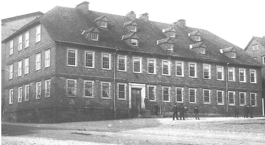
Abbildung 23: Altes Bergschulgebäude, erweitert 1831
