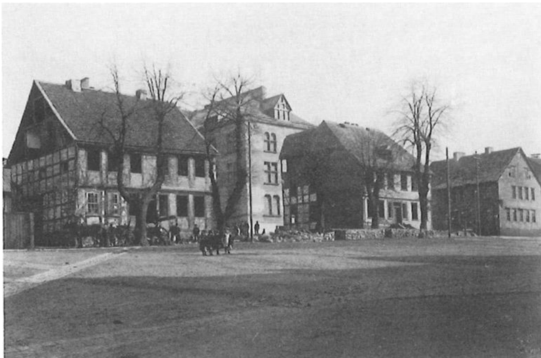
Abbildung 30: Abriss der drei Häuser. Neubau des Hüttenmännischen Gebäudes März 1903.
