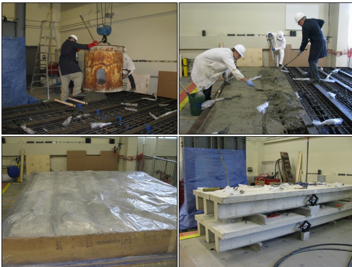
Figure 3. 4 Bétonnage et mûrissement des poutres LS-RW et LS-RF
