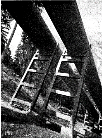
Figure 2 - A gauche, conduite forcée. A droite, sortie d'un puits blindé – [1]
