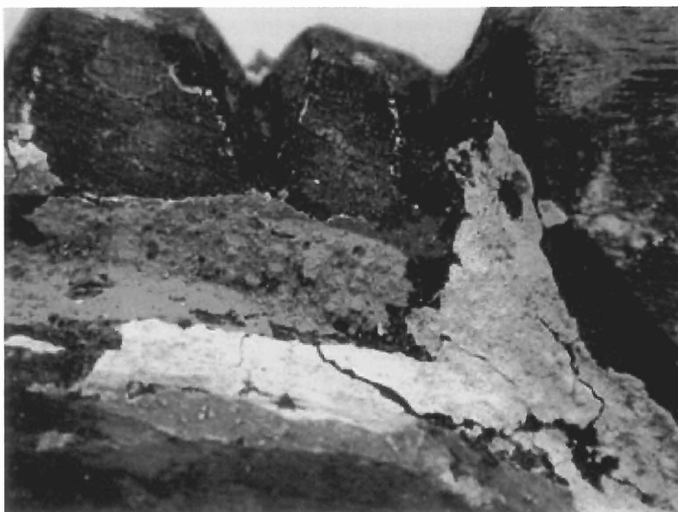
Photo 38 Détail de la peinture jaune, pulvérulente et de la peinture blanche, formant des écailles.
