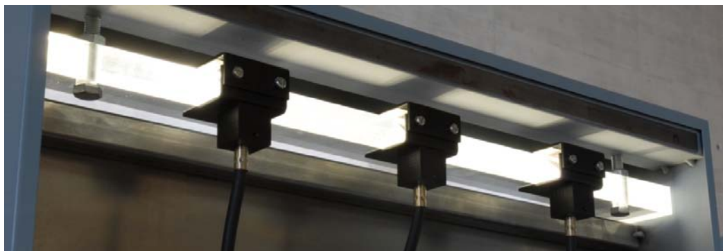
III. 25 Dispositif de l'éclairage LED dans les vitrines « lacustres » du Laténium, le dispositif est composé de barrettes LED, d'une optique en Plexiglas® placé devant les diodes et d'un support en U métallique (©Laténium, 2011)
