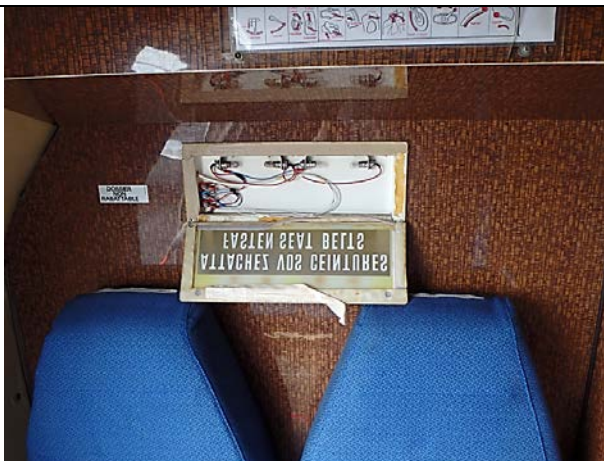
Figure 14 Dégradation des installations techniques
