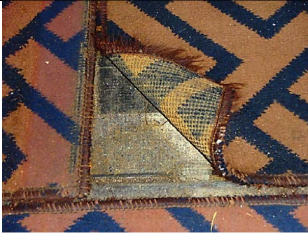
Figure 10 Soulèvement de la moquette
