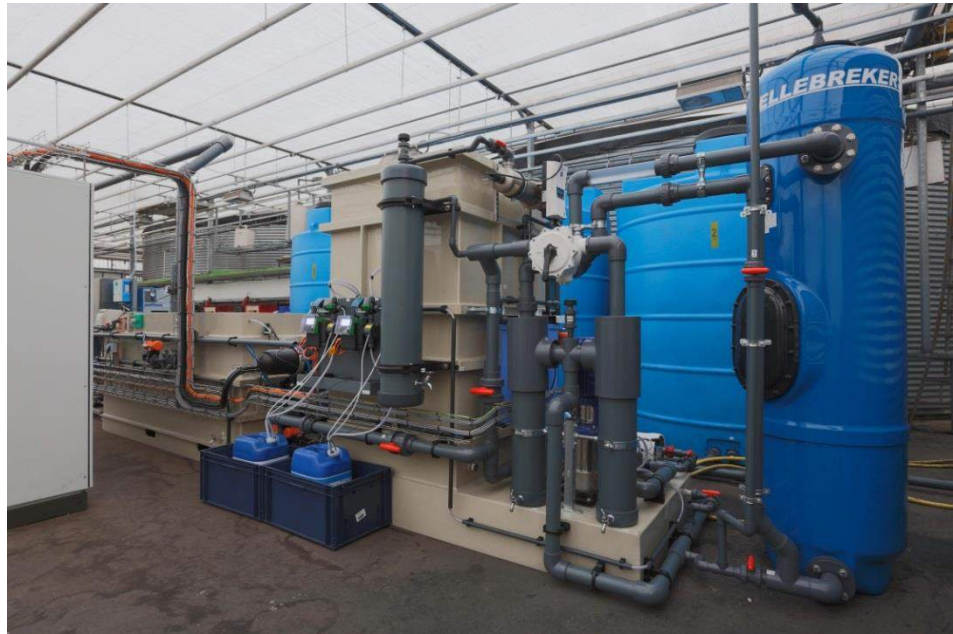
Figuur A-3 Zijaanzicht met tussenopslag (links) met AOP daaraan bevestigd en de installatie voor actief kool adsorptie (rechts).
