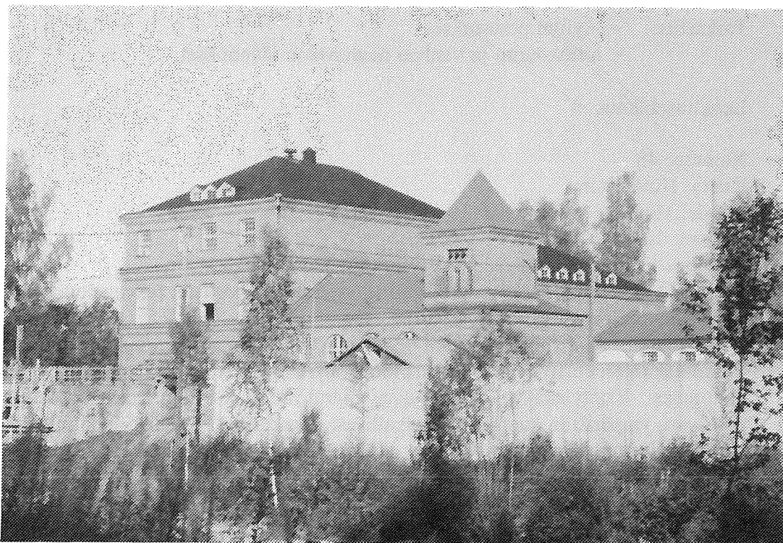
Kuva 4. Kissakosken voimalaitos. Vanha tehdasrakennus.
