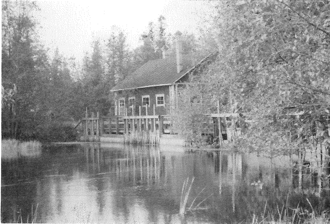
Kuva 8. Läsäkosken mylly. Patorakenteet ja Myllysaaren vesilaitos.
