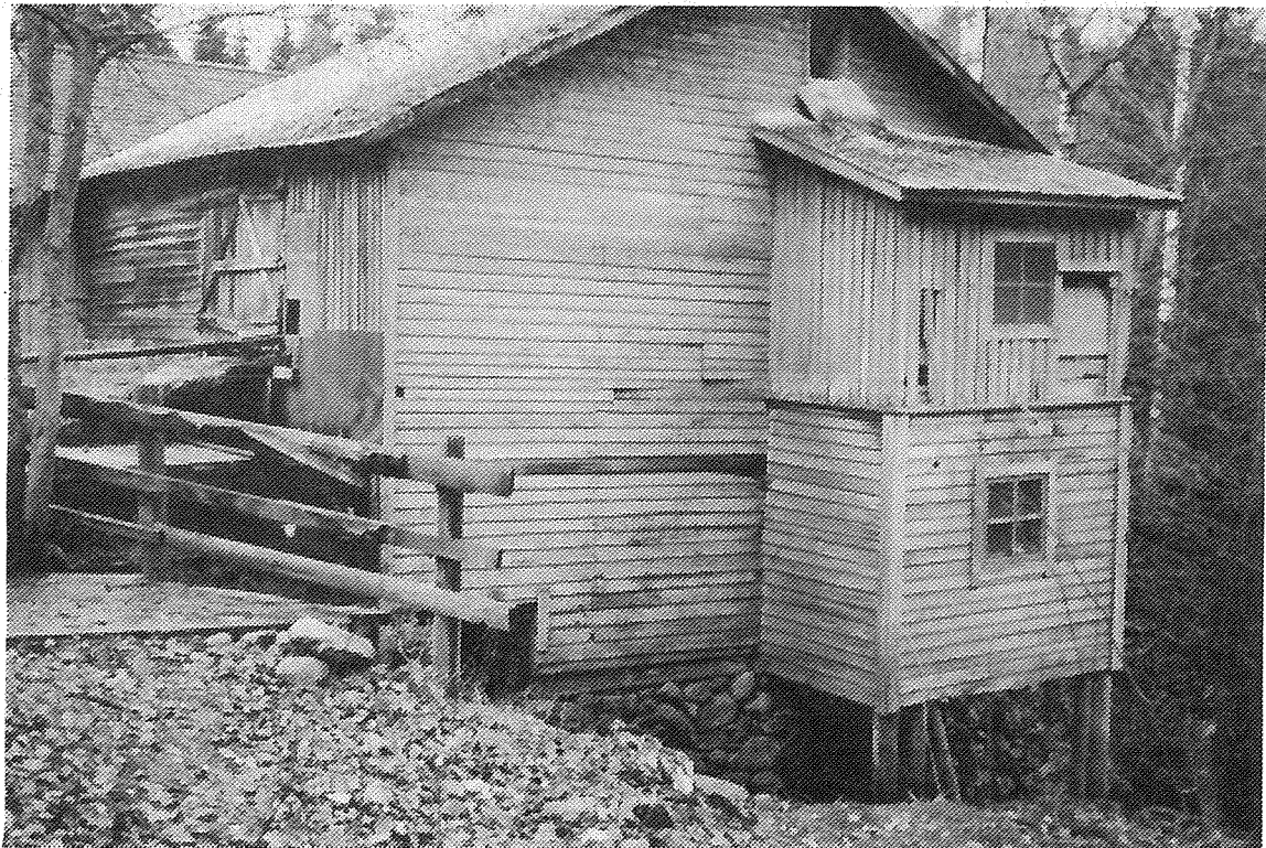
Kuva 1. Vuorikosken mylly. Myllyrakennus alavirran puolelta päin.
