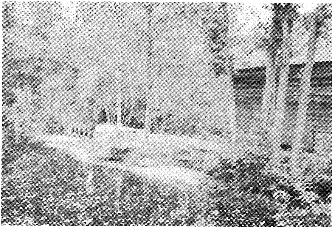
Kuva 9. Harjukosken mylly. Mylly- ja patorakenteet.
