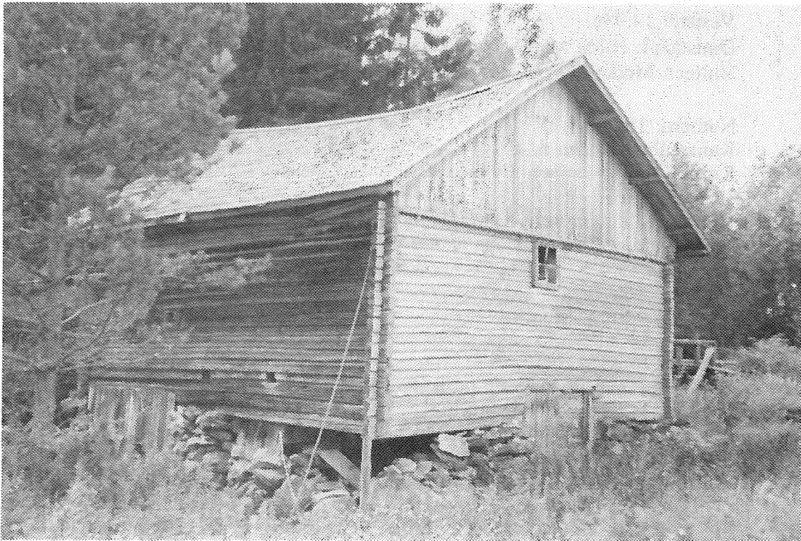
Kuva 11. Kannonlahden mylly. Myllyrakennus.
