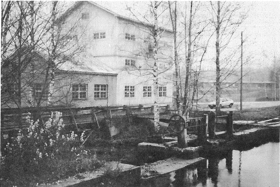
Kuva 16. Vuokalankoski. Mylly ja voimalaitos.
