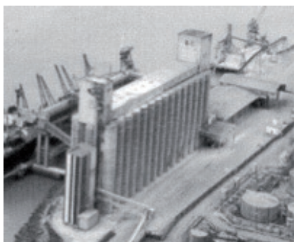
FIG. 2.8 – Silo avant l'accident.
