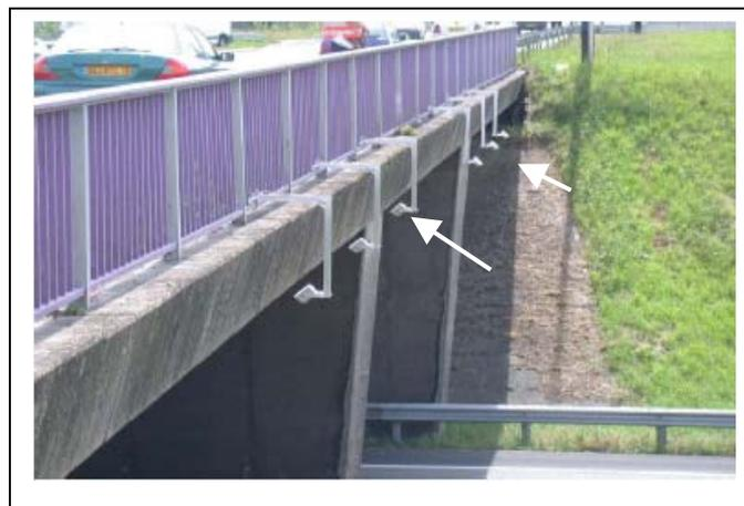
Figure 0.2 Détecteur IR utilisés sur l'autoroute A13 pour une application de calcul du temps de parcours[Ferré 2003].
