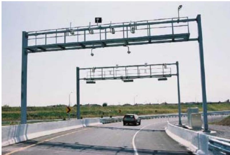
Figure 0.1 Portique supportant les lecteurs des transpondeurs et les caméras vidéo
