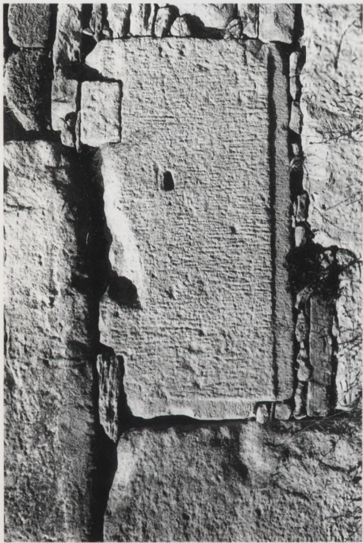
Bloc de remplissage dans le mur de renforcement de l'abside.
