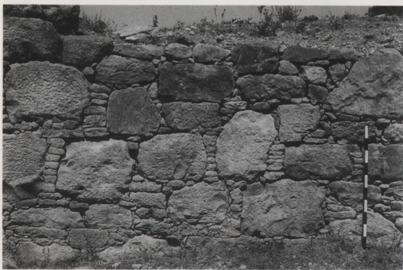
b: Mur de l'abside.
