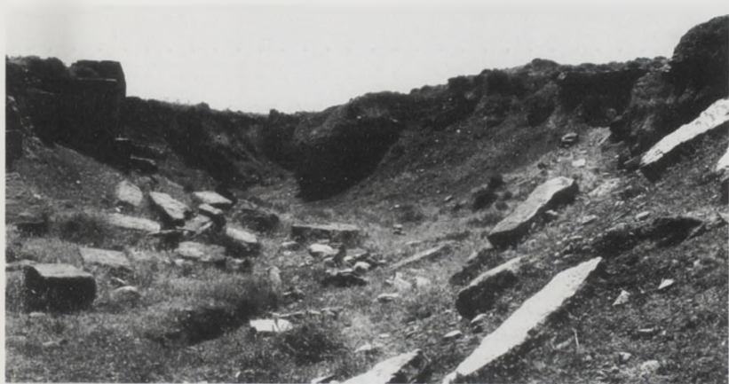
a: Note 16. Le ponceau effondré, à l'emplacement même du ravin antique.
