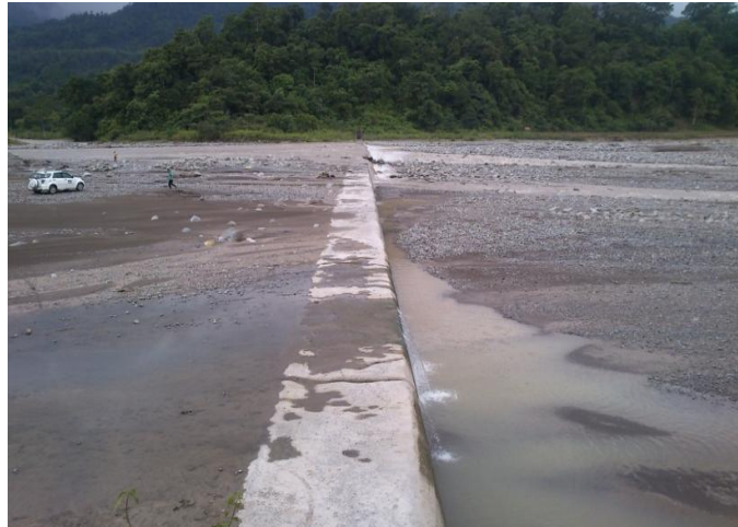
Gambar 2.3 Pengendapan sedimentasi di Sabo Dam
