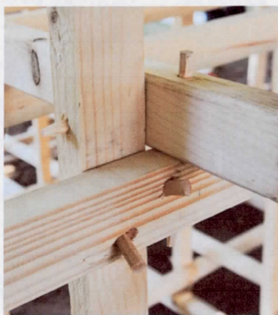
Figure 5.3 : Détail d'assemblage avec des chevilles.
