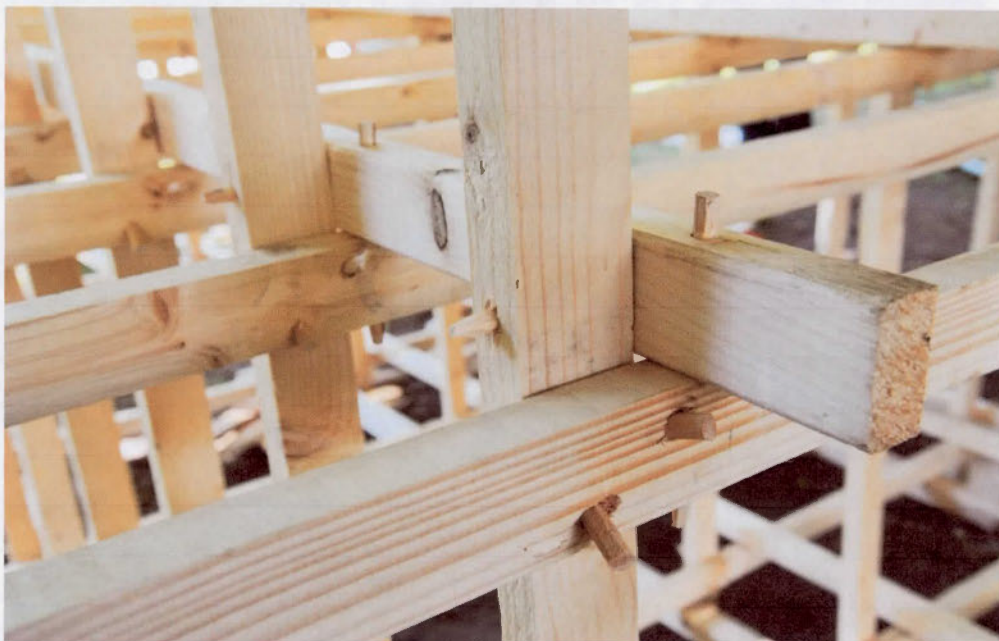
Figure 2.2 : Assemblage 2D avec les chevilles
