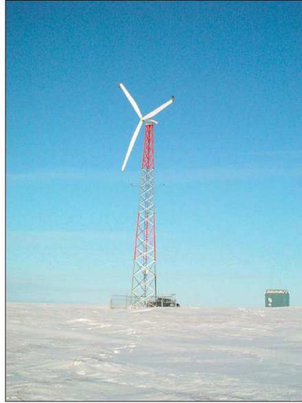
FIG. II-7 – ÉOLIENNE DE 50 kW RELIÉE À UN RÉSEAU ISOLÉ DANS L'ARCTIQUE [RET]
