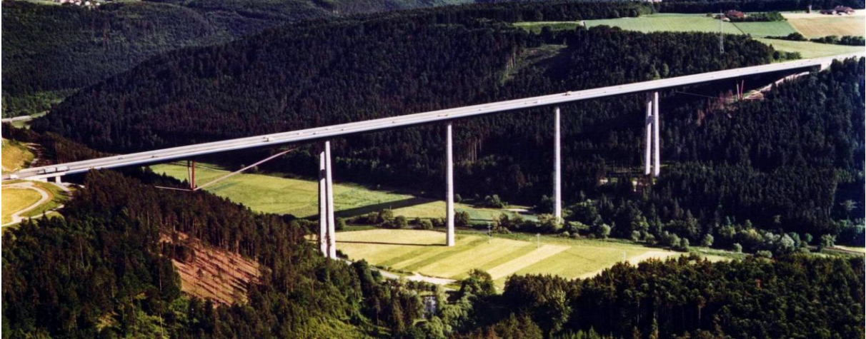
Figure 2: Weitingen viaduct (courtesy of Holger Svensson, Leonhardt Andrä und Partner)
