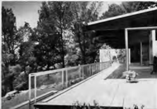
Un amplio balcón frente al estar vuela sobre el área de la piscina.
