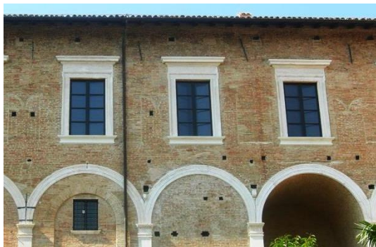
79 Alcune tracce delle antiche merlature. (da https://it.wikipedia.org/wiki/File:Cortile_Pasquino_Palazzo_Ducale_Urbino.JPG )
