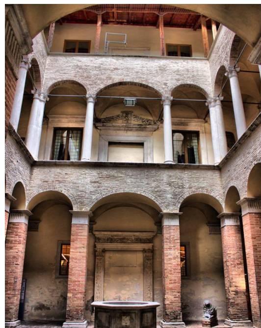
138 Immagine attuale dei tre ordini del cortile, con il terzo lasciato incompiuto. (da http://www.panoramio.com/user/3054145?comment_page=1&photo_page=4 )
