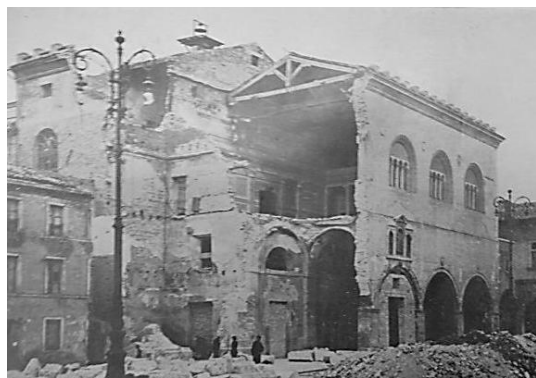
246 La parte del Palazzo distrutta dal crollo della torre. (da Pacini, Pacini 2010, p. 77)
