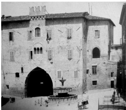
21 Prove per il coronamento merlato. (da BCF, cartella Palazzo del Podestà, Documentazione ingegner Bocci Icilio )
