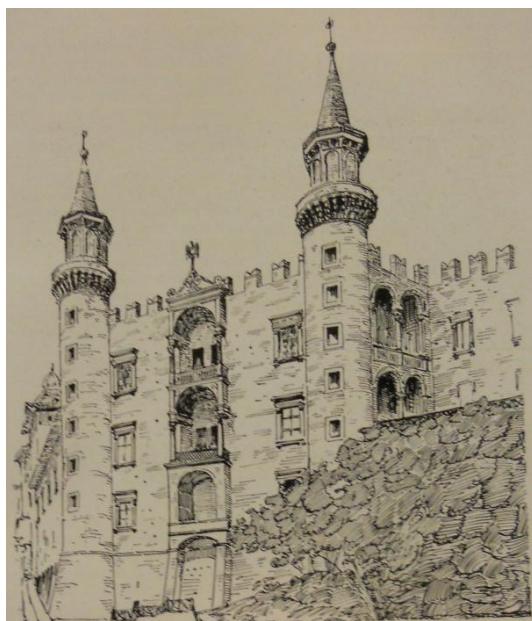
76 La facciata dei Torricini disegnata dall'arch. (Serra 1934, p. 23)
