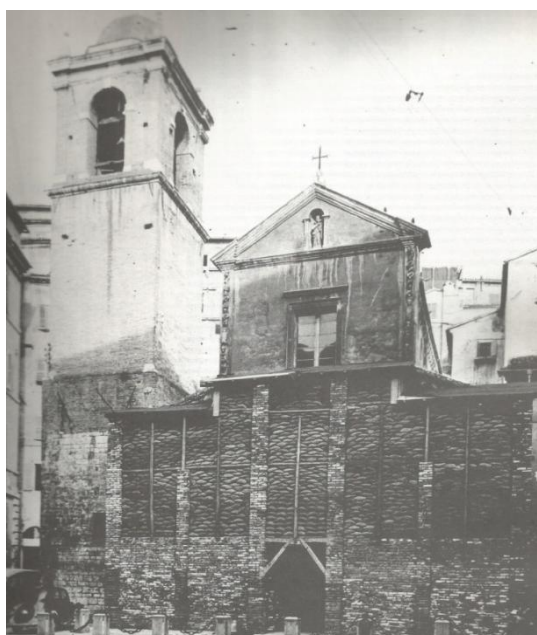
195 Strutture di legno con le sacchettature di sabbia. (da Canti Polichetti 1981, p. 79)
