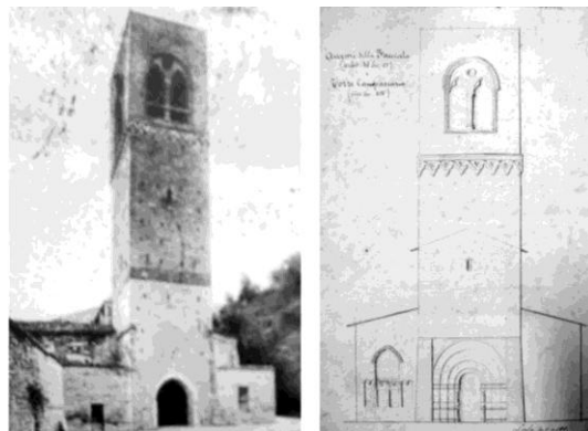
10 Confronto tra la facciata prima del restauro ed il progetto di riapertura delle monofore (attuato) e della ricostruzione del portale. (da BCF, cartella San Lorenzo in Doliolo, Documentazione ingegner Bocci Icilio )
