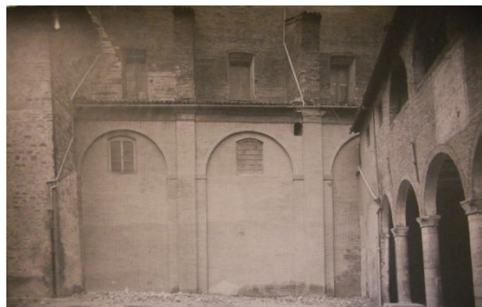
67 Termine dei lavori con eliminazione della superfetazione. (da BCF, Icilio Bocci, Restauro della Cattedrale di S. Venanzo e del Palazzo Vescovile di Fabriano )
