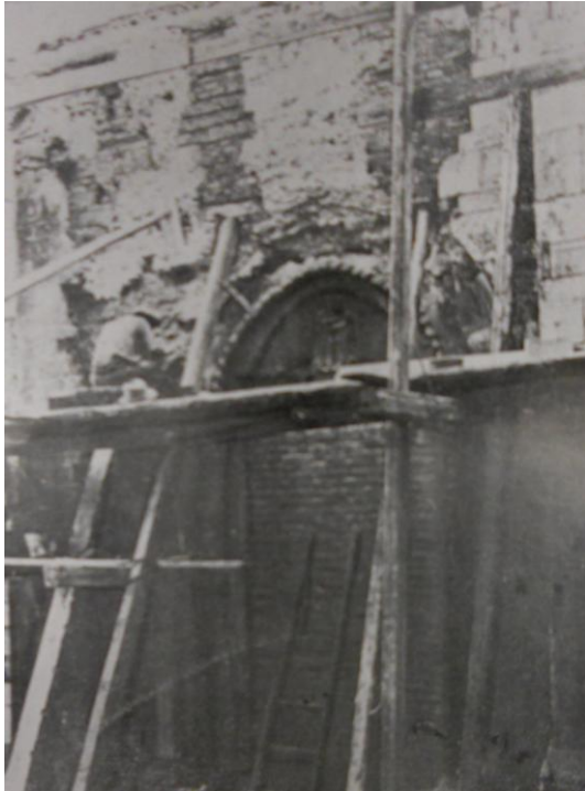
196 Consolidamento della muratura del fianco destro e ricomposizione del portale laterale. (da Soprintendenze per le Antichità delle Marche e dell'Umbria, per le Gallerie delle Marche 1946, p. 77)
