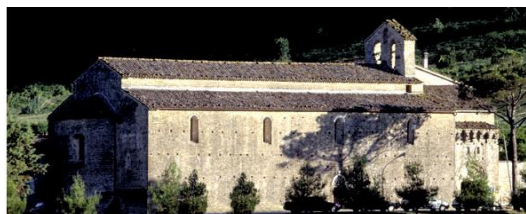
39 Veduta dell'abbazia dalla strada di accesso. (Foto 2015)
