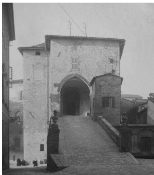
19 Rampa di accesso con la casetta del boia. (da BCF, cartella Palazzo del Podestà, Documentazione ingegner Bocci Icilio )
