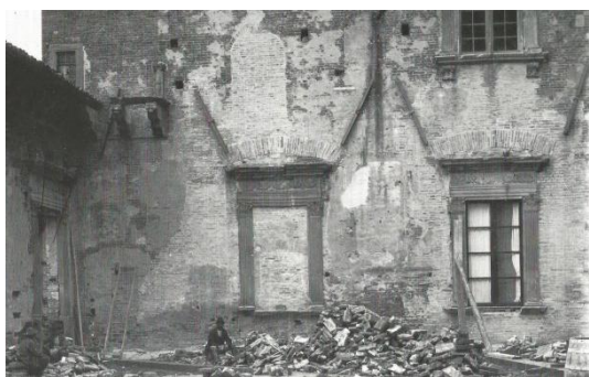
88 Situazione del giardino nel 1905 dopo le manomissioni dovute all'adattamento del Castellare a carcere. (da Canti Polichetti 1985, p. 540)
