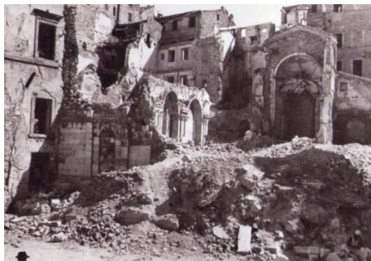
200 La chiesa totalmente distrutta – 1944. (da http://www.fattodiritto.it/io-anconetana-sotto-il-cielo-della-ii-guerra-mondiale/ )
