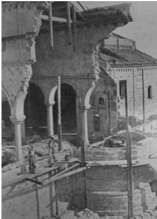
193 Ricostruzione dell'abside del braccio destro del transetto. (da Soprintendenze per le Antichità delle Marche e dell'Umbria, per le Gallerie delle Marche, 1946, p. 101)
