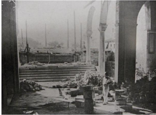
192 Ricostruzione dell'abside del braccio destro del transetto. Sono visibili i blocchi di pietra recuperati e sistemati all'interno. (da Soprintendenze per le Antichità delle Marche e dell'Umbria, per le Gallerie delle Marche, 1946, p. 93)
