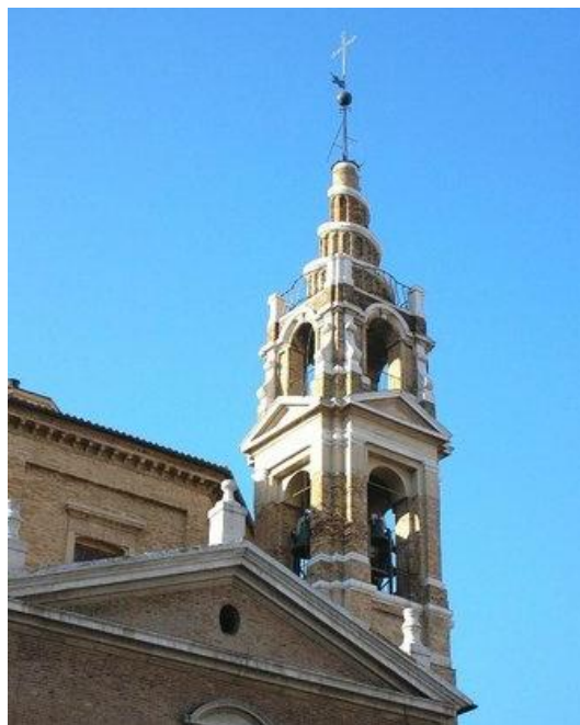
204 Particolare del campanile elicoidale. (Foto 2016)
