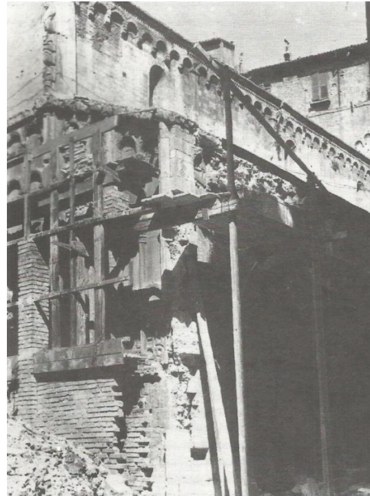
197 Lavori di consolidamento dell'angolo destro. (da Canti Polichetti 1981, p. 80)
