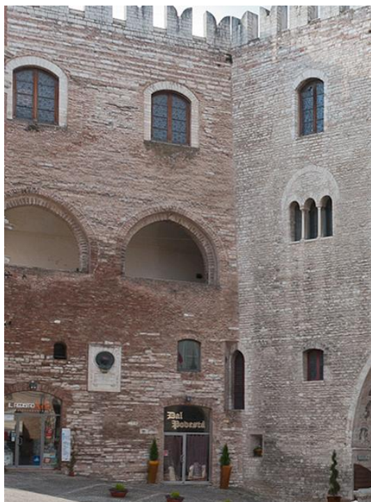
13 Particolare dell'innesto tra il corpo di sinistra e quello centrale. (Foto 2014)
