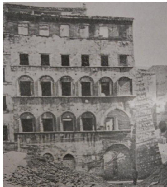
222 Fotografia della facciata del palazzo lesionata dalle bombe con lo sperone di sostegno laterale. (da Soprintendenze per le Antichità delle Marche e dell'Umbria, per le Gallerie delle Marche 1946, p. 69)
