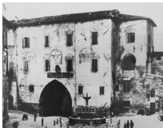
15 La facciata con tracce delle trifore sotto l'intonaco – XIX sec. (da BCF, cartella Palazzo del Podestà, Documentazione ingegner Bocci Iulio)
