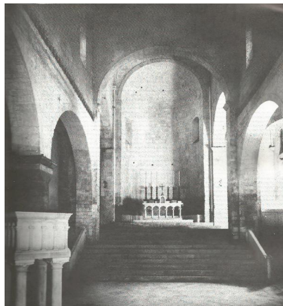
148 L'interno dopo l'intervento. (da Canti Polichetti 1981, p. 77)
