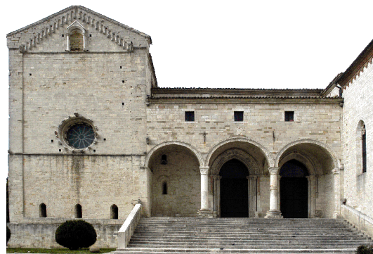
31 Facciata della chiesa. (Foto 2015)
