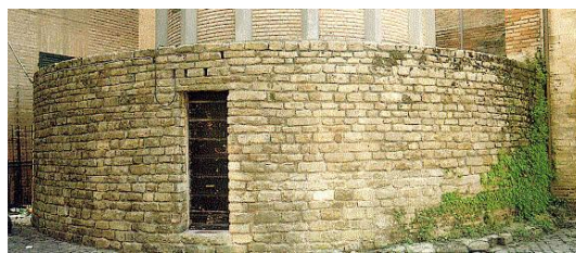
255 La base dell'antico campanile in arenaria. (da Volpe 2015, p. 257)
