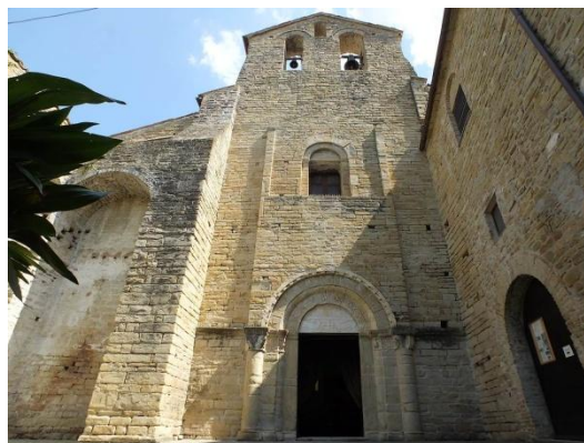
40 La facciata eretta all'interno delle mura di confine. (Foto 2015)
