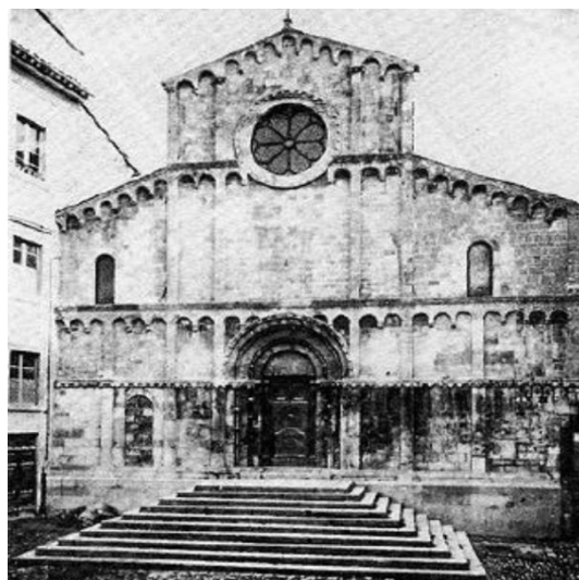
154 Foto del prospetto principale restaurato. (da http://www.anconanostra.com/ancona_antiga/ceranavolta/san_pietro/sanpietro1.htm )
