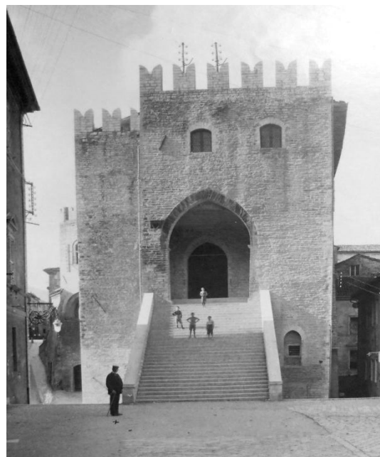
20 Lavori di ripristino terminati. (da BCF, cartella Palazzo del Podestà, Documentazione ingegner Bocci Icilio )
