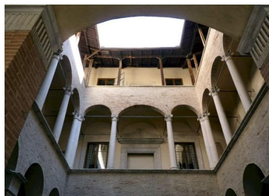
135 Veduta del secondo e terzo ordine del cortile, sorretto dai pali di rovere. (da http://www.panoramio.com/user/3054145?comment_page=1&photo_page=4 )
