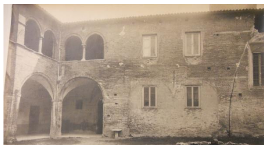
68 Pareti del chiostro con due arcate tamponate. (da BCF, Icilio Bocci, Restauro della Cattedrale di S. Venanzo e del Palazzo Vescovile di Fabriano )
