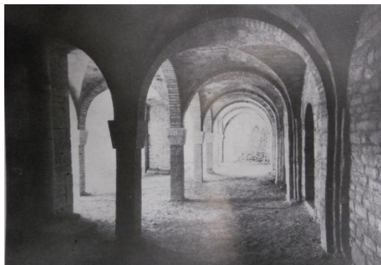
108 Veduta attuale della cripta con i capitelli a piramidi tronche rovesciate in pietra. (da Pierucci 1981, p. 65)
