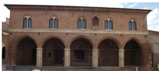
163 Prospetto principale del complesso che affaccia sulla piazza della Cattedrale. (Foto 2013)
