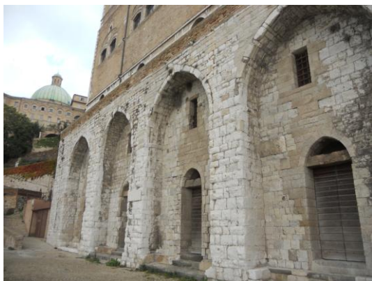
230 Le possenti strutture medievali del Palazzo. (Foto 2016)
