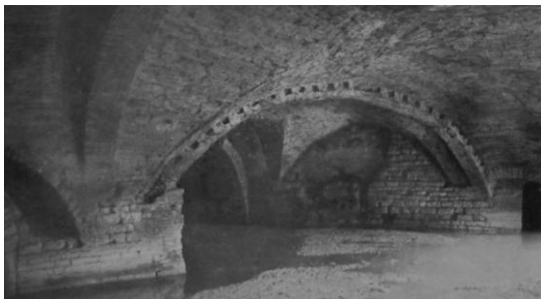
1 Immagine delle volte del ponte. (da Bocci 1908, p. 7)
