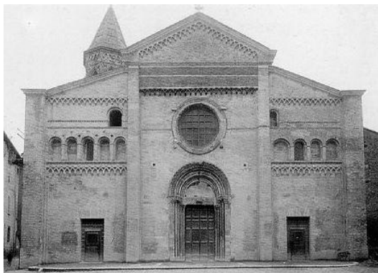
162 La facciata al termine dei lavori di ripristino nel 1929. (da http://www.fondazionekarifano.it/Progetti/DuomoFano/DuomoFanoCapitoloIII_5.html )
