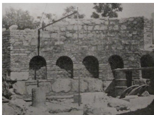
191 Elevazione dei muri dell’abside in mattoni. (da Soprintendenze per le Antichità delle Marche e dell’Umbria, per le Gallerie delle Marche, 1946, p. 93)
