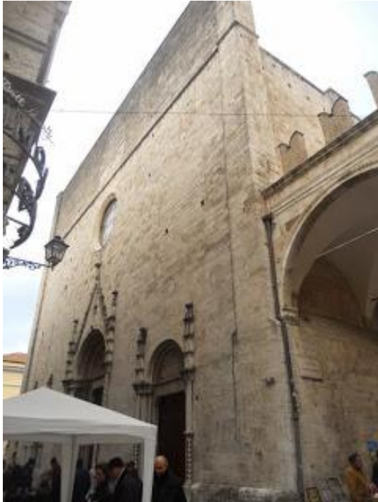
182 Veduta della facciata dall'angolo della loggia dei Mercanti. (Foto 2016)
