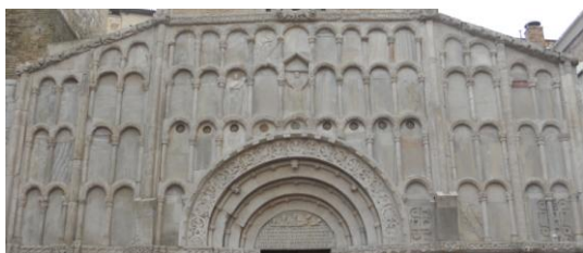
143 Particolare della zona inferiore. (Foto 2015)
