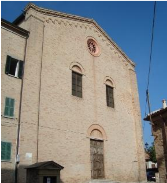
262 La facciata della ex chiesa di Sant'Agostino. (Foto 2016)
