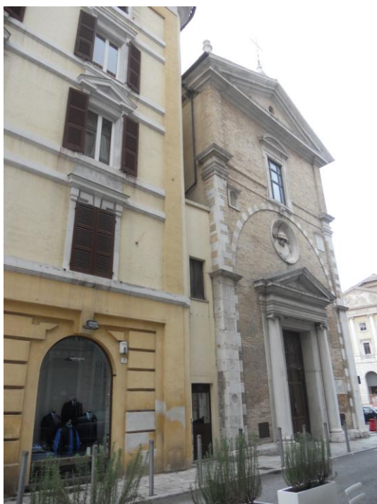
203 Veduta della facciata e del palazzo addossato al fianco sinistro. (Foto 2016)
