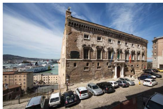
227 Il prospetto posteriore del Palazzo rivolto verso la città e la chiesa del Gesù. (da http://www.impresagaspari.it/realizzazione/palazzo-degli-anziani-di-ancona/ )
