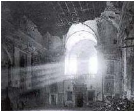
263 Foto d'archivio dell'interno della chiesa, verso l'ingresso, con le macerie raccolte e la volta crollata. (da Volpe 2011, p. 43)
