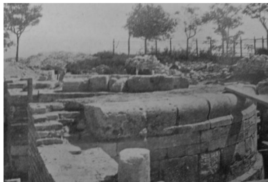
190 Ricostruzione del basamento dell’abside con i blocchi di tufo ricollocati al proprio posto. (da Soprintendenze per le Antichità delle Marche e dell’Umbria, per le Gallerie delle Marche, 1946, p. 84)
