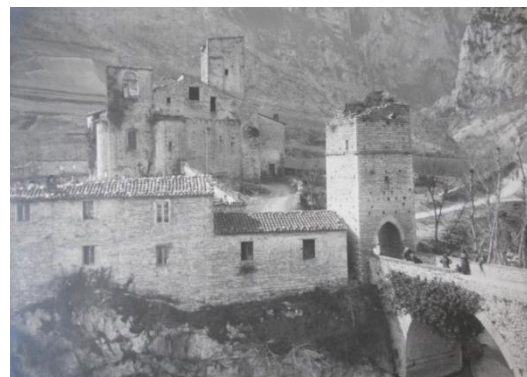
109 Veduta del ponte, della torre e della chiesa, in secondo piano, prima del restauro di inizio ‘900. (da ASA AN 337)
