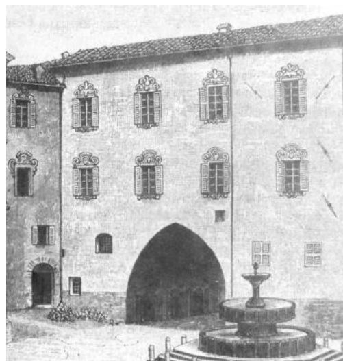
12 Immagine del XVIII secolo con il paramento intonacato, le finestre rettangolari e assenza di merlatura. (da BCF, cartella Palazzo del Podestà, Documentazione ingegner Bocci Icilio )
