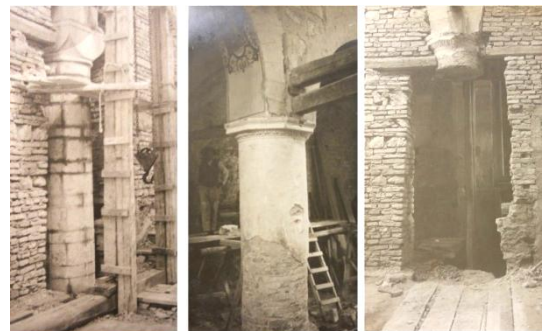
6 Lavori di demolizione della muratura e conseguente scoperta dei pilastri in pietra ed in mattoni. (da BCF, cartella San Lorenzo in Doliolo, Documentazione ingegner Bocci Icilio )
