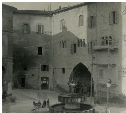
17 Foto dei lavori di ripristino avviati con le tre trifore del piano primo aperte. (da BCF, cartella Palazzo del Podestà, Documentazione ingegner Bocci Icilio )
