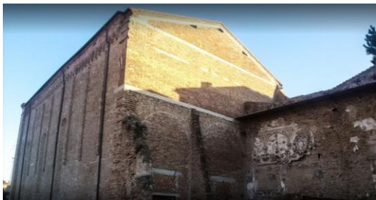
275 Veduta attuale della parete di “bloccaggio”. (Foto 2016)
