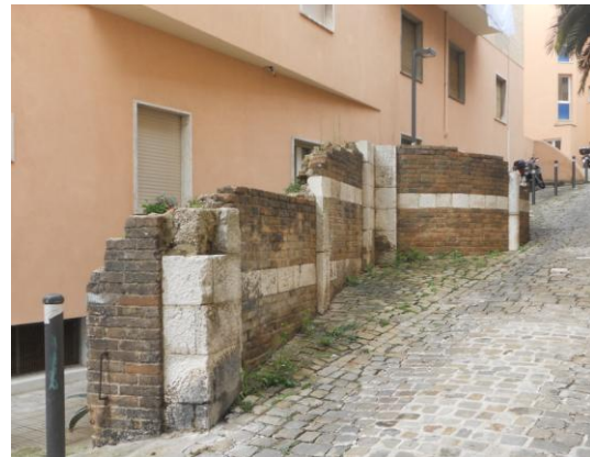
151 Resti del basamento dell'abside (Foto 2016)
