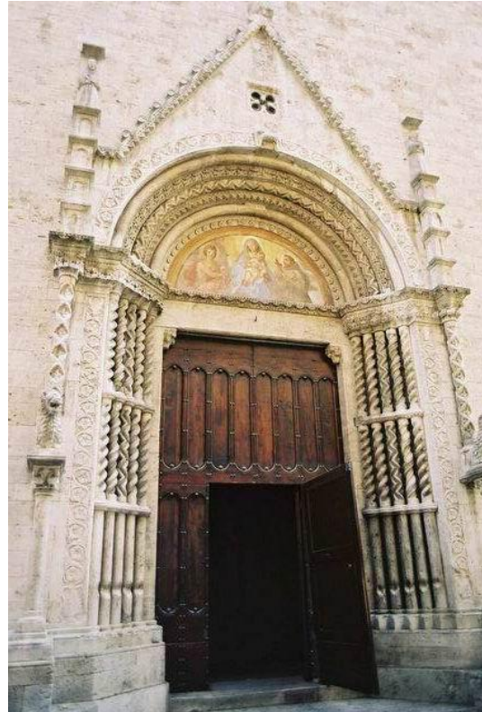
183 Particolare del portale centrale. (Foto 2016)
