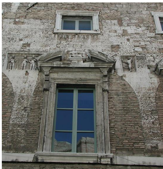
234 Dettaglio delle strutture portanti in pietra delle logge, sulle quali sono incastonati i pannelli scultorei, chiuse per ospitare le finestre seicentesche. (Foto 2016)
