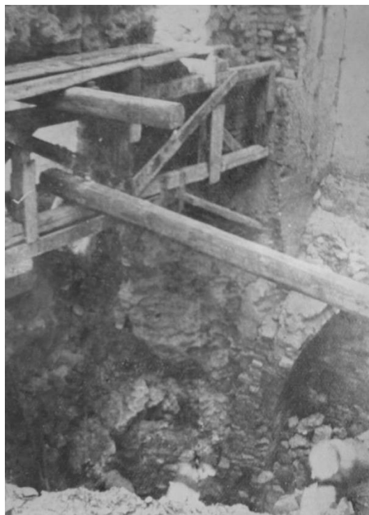
236 Lavori di consolidamento: trave di puntellamento posta nella breccia della parete a monte. (da Soprintendenze per le Antichità delle Marche e dell'Umbria, per le Gallerie delle Marche 1946, p. 100)
