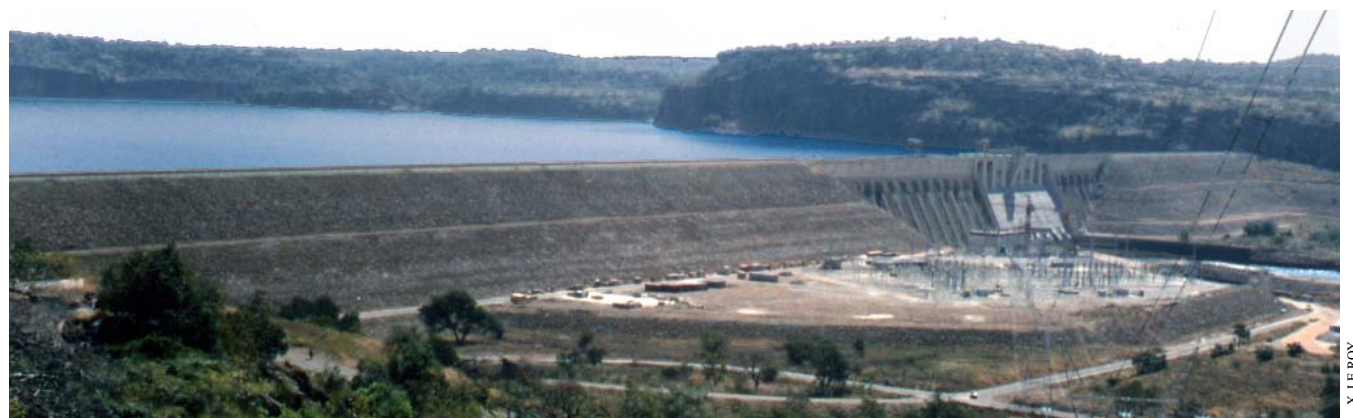
Figure 10. Barrage de Manantali
